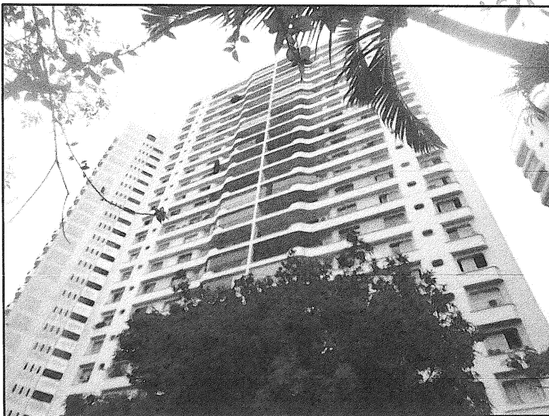
Vista do imóvel avaliando
