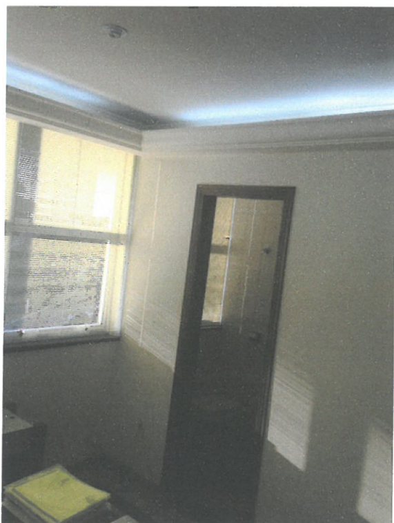
FOTO 06 – Sala 1 com vista do Banheiro 1
