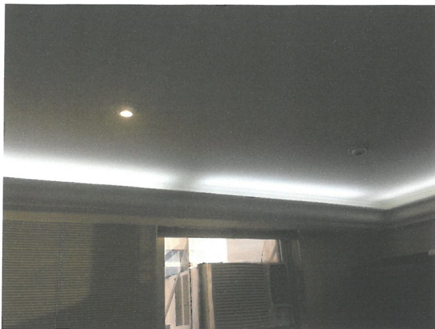
FOTO 19 – Sala 2 – Vista do teto e sanca de gesso
