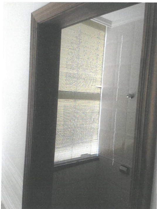
FOTO 07 – Banheiro 1 – Vista a partir da Sala 1
