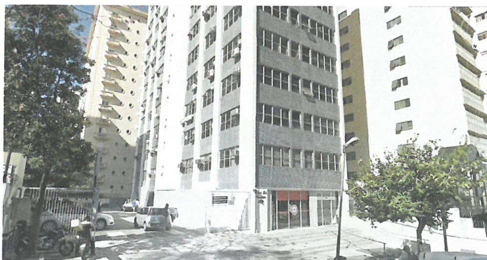
FOTO 02 – Fachada Edifício Natalie
