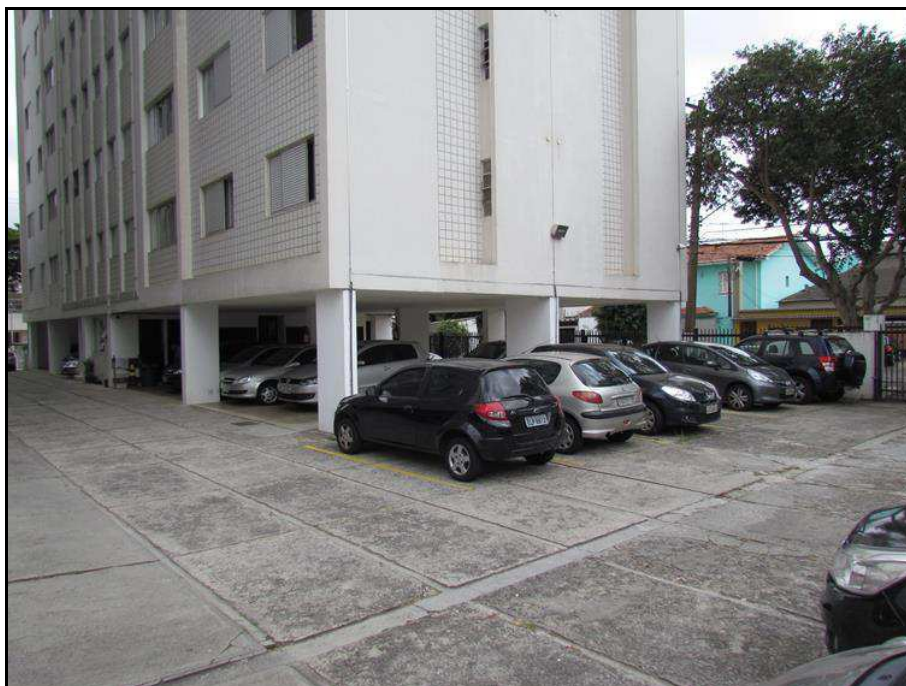
FOTO 16: Vista da garagem coletiva do Edifício Catiguá.
