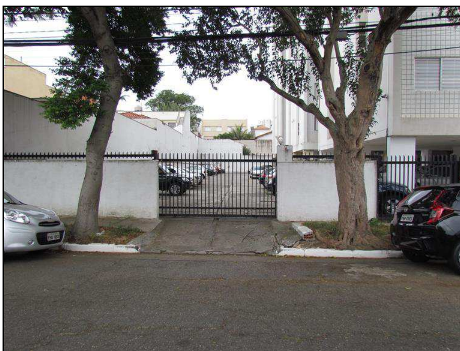
FOTO 17: Vista da entrada para a garagem do Edifício Catiguá.
