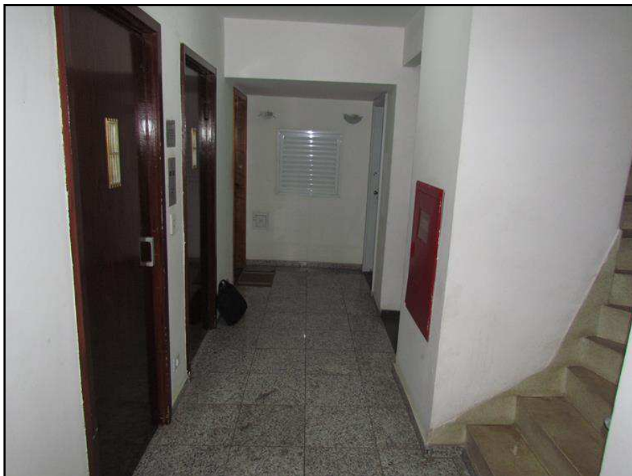
FOTO 15: Vista do hall do elevador e apartamentos do 1º andar do Edifício Catiguá.
