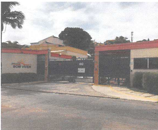
Aspecto da portaria avançada e da entrada de veículos.
