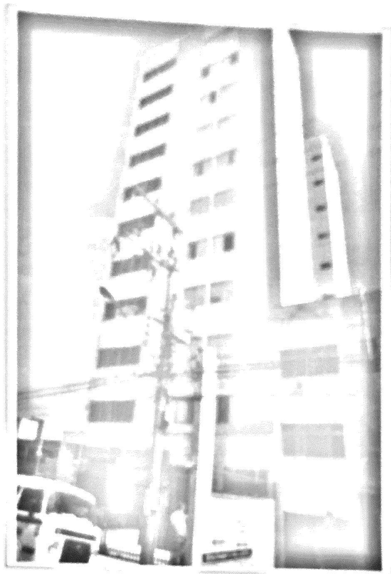
Foto 03: Vista da fachada do Edifício Tobias Muzaiel sob nº 581 da Rua Senador Fonseca.
