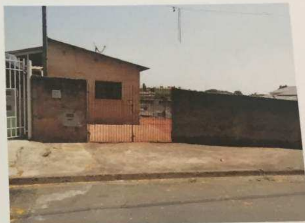
FOTO N.º 22- Tomada frontal do imóvel avaliando, situado à Rua Orlando de Oliveira, n.º 807.
