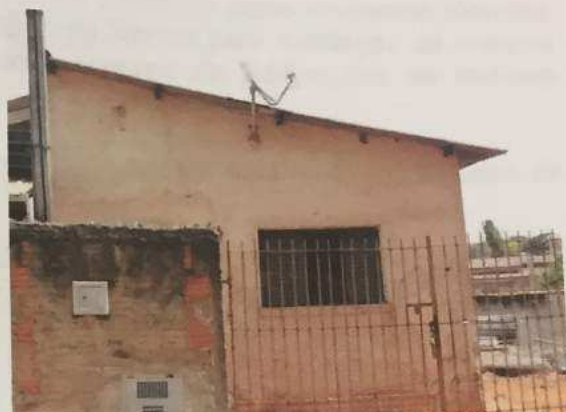
FOTO N.º 24- Vista externa da edificação existente no imóvel avaliando.
