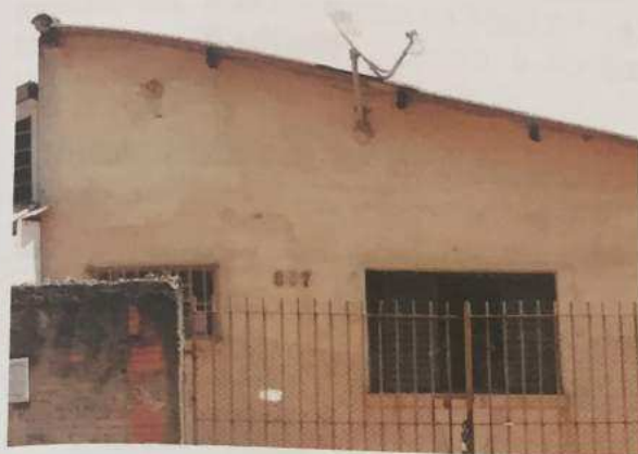
FOTO N.º 23- Aspecto externo da edificação existente no imóvel avaliando, com a identificação do n.º 807 da Rua Orlando de Oliveira.
