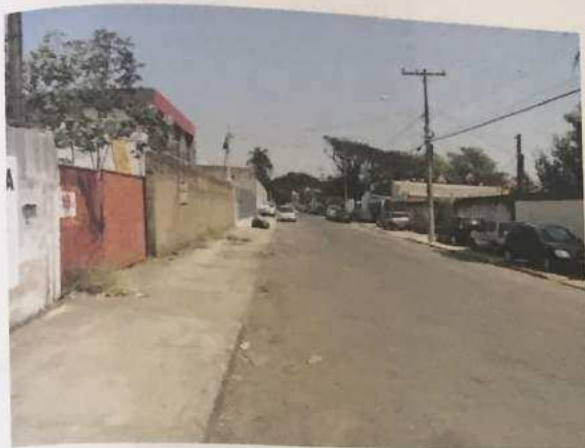
FOTO N.º 01- Aspecto da Rua Francisco Ceará Barbosa, no sentido da Av. Neyde Modesto de Camargo.
