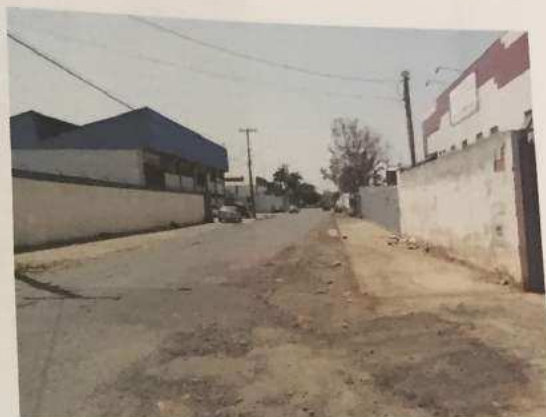
FOTO N.º 02- Vista da Rua Francisco Ceará Barbosa, no sentido da Rua Gustavo Stuart.
