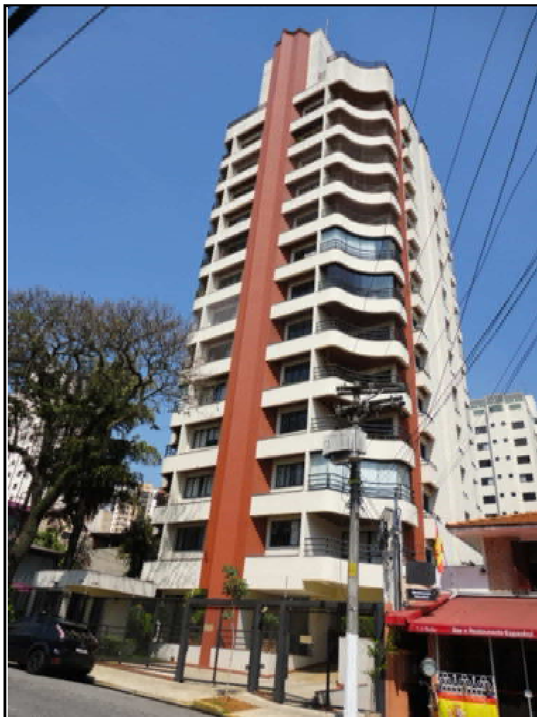
Foto 1: Vista frontal do Edifício Village Campo Belo
