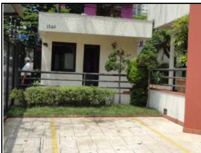
Foto 4: Entrada principal do Edifício Village Campo Belo
