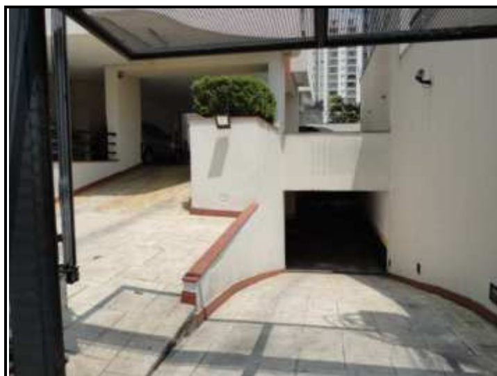
Foto 50: Rampa de acesso à garagem no subsolo
