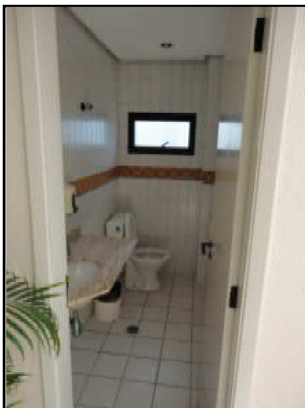
Foto 39: Cobertura: banheiro feminino
