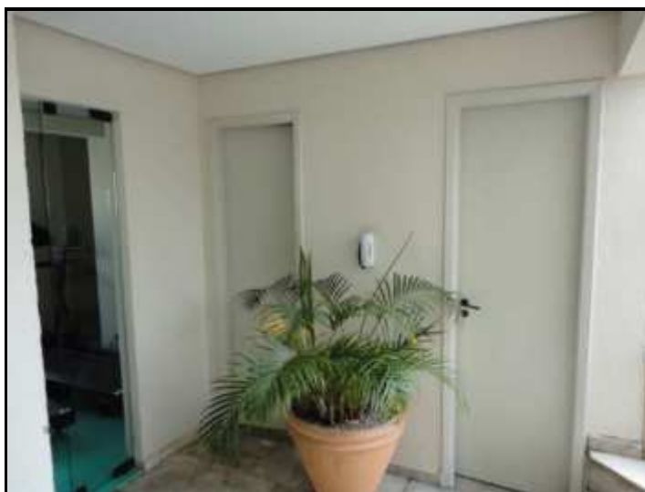
Foto 40: Cobertura: vista da sala de ginástica e os banheiros masculino e feminino
