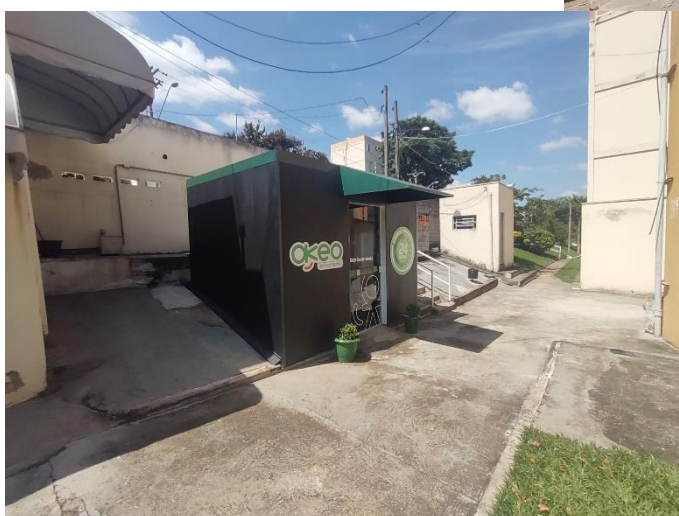
Fotos nos. 17, 18, 19 e 20 - Vista da quadra de esportes, da praça e mercado Smart do Condomínio.
