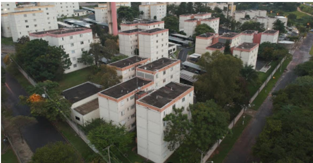
Foto no. 1- Vista do Condomínio.
