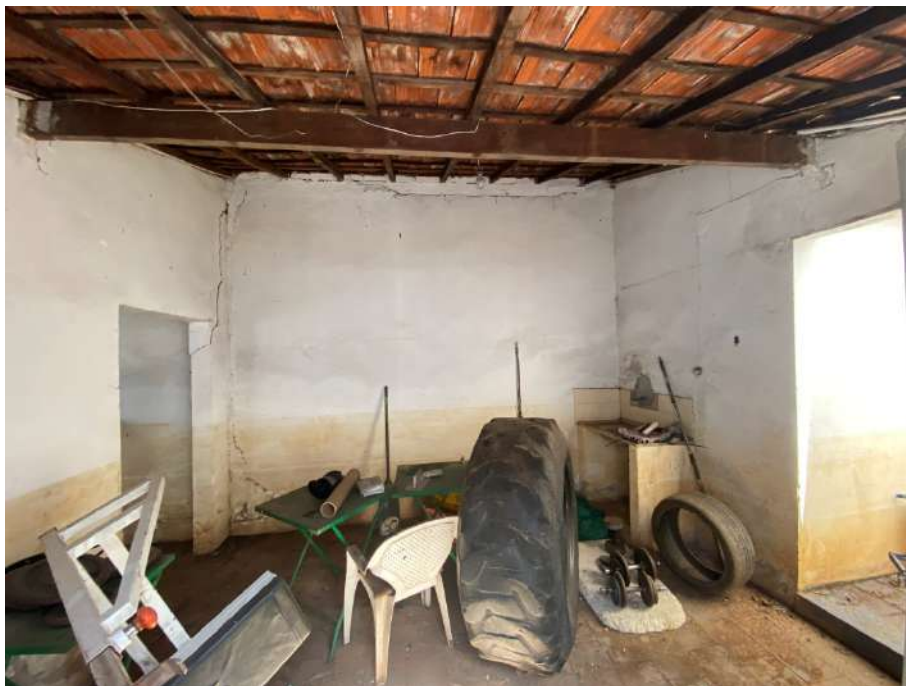
VISTA DA COZINHA.
