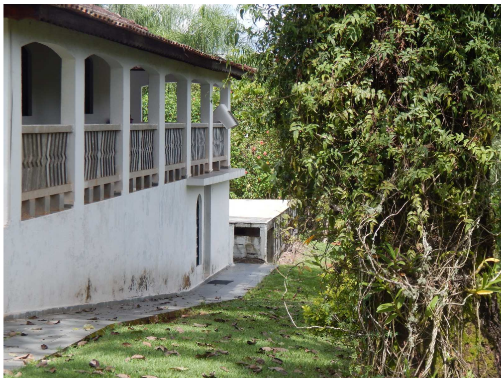
Foto 7 – Lateral direita do imóvel.
