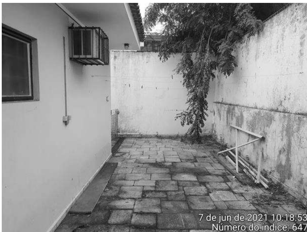
Foto 06 – Fundo do imóvel
