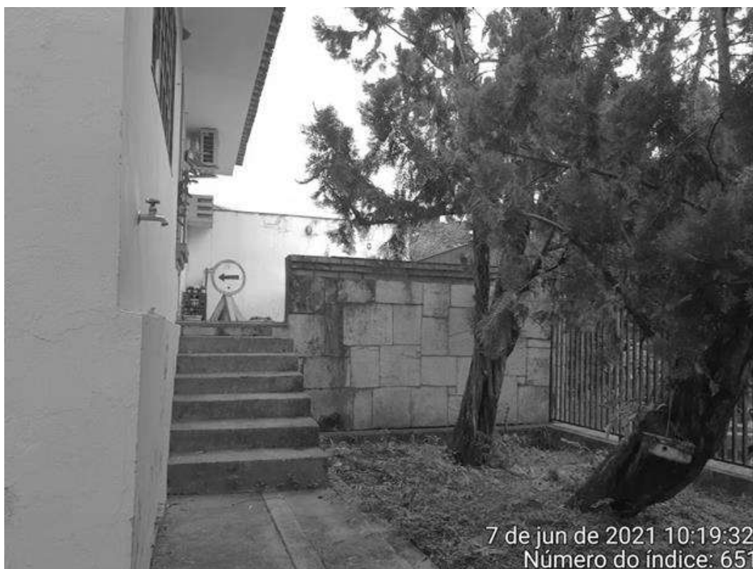
Foto 07 – Acesso ao terraço sobre a garagem
