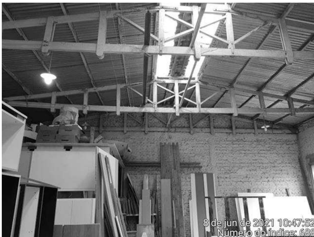
Fotos 28 – Fundo do imóvel
