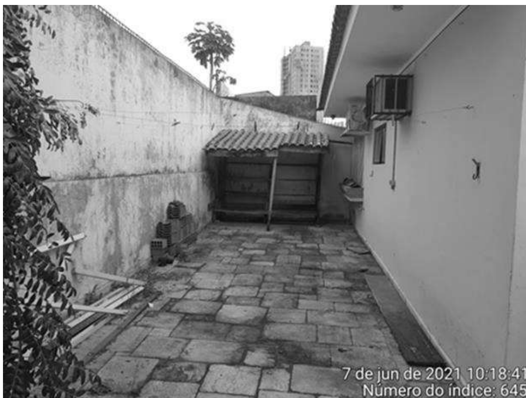
Foto 05 – Fundo do imóvel
