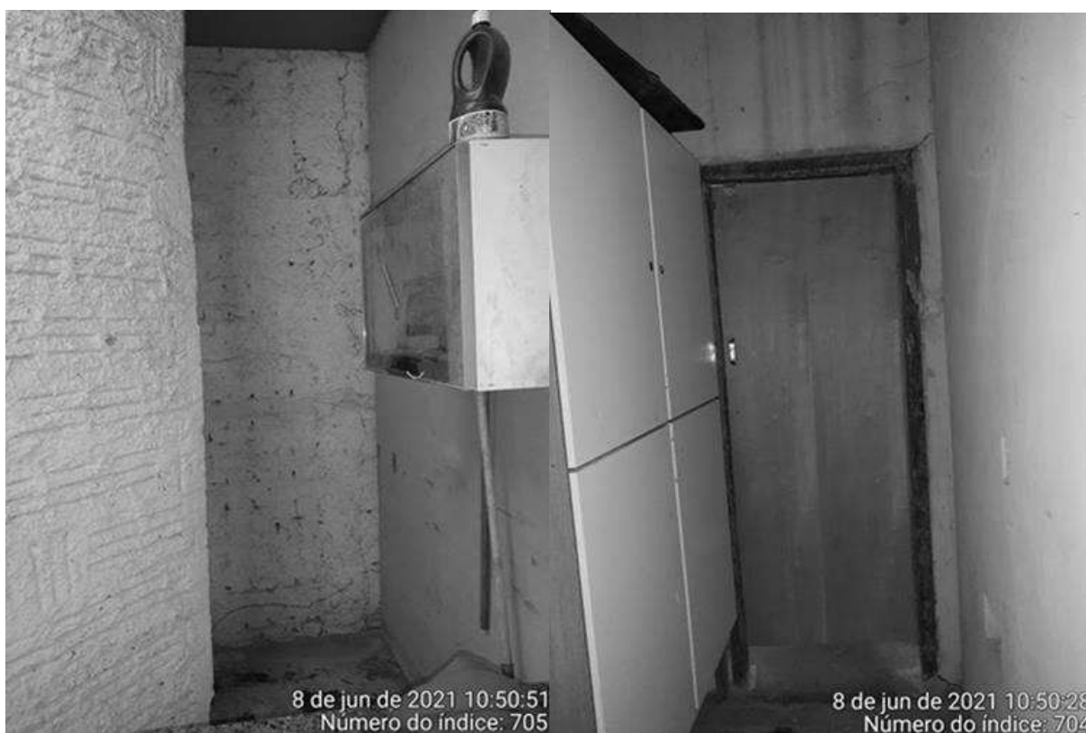
Fotos 30 – Acesso ao banheiro
