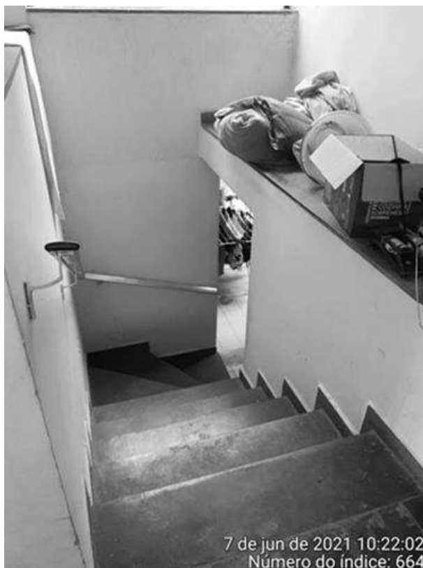
Fotos 21 - Acesso área de serviço
