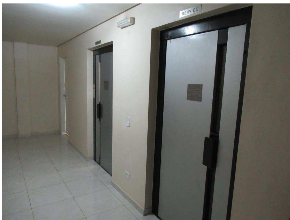
Foto nº. 20 – Vista dos elevadores localizados no 4º andar do Edifício Q.
