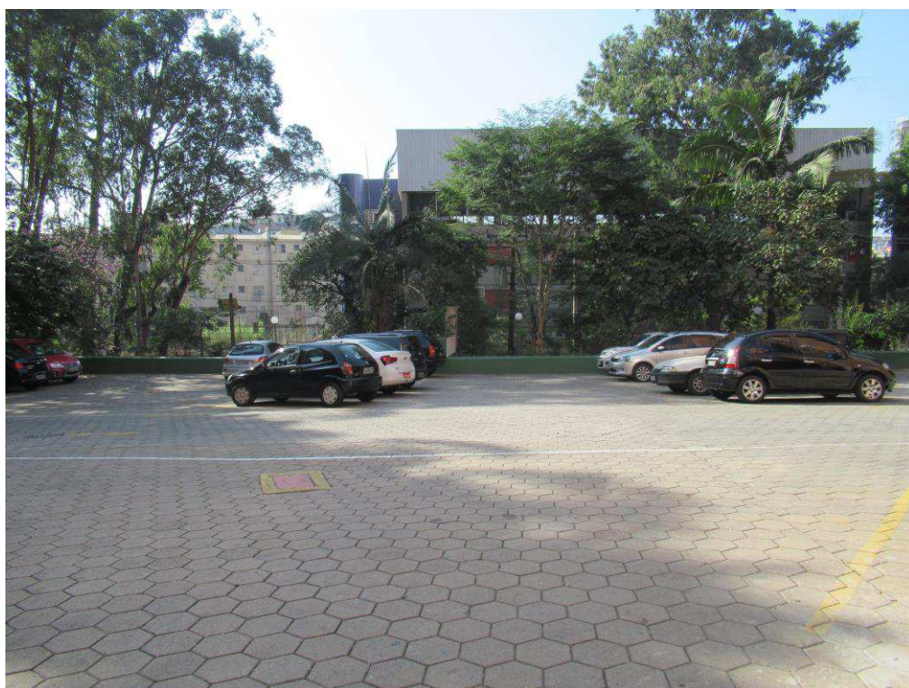
Foto nº. 7 – Vista parcial do estacionamento localizado no pavimento térreo.
