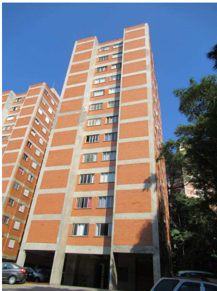
Foto nº. 6 – Vista da fachada do Edifício Q, onde se localiza o imóvel avaliado no presente laudo.
