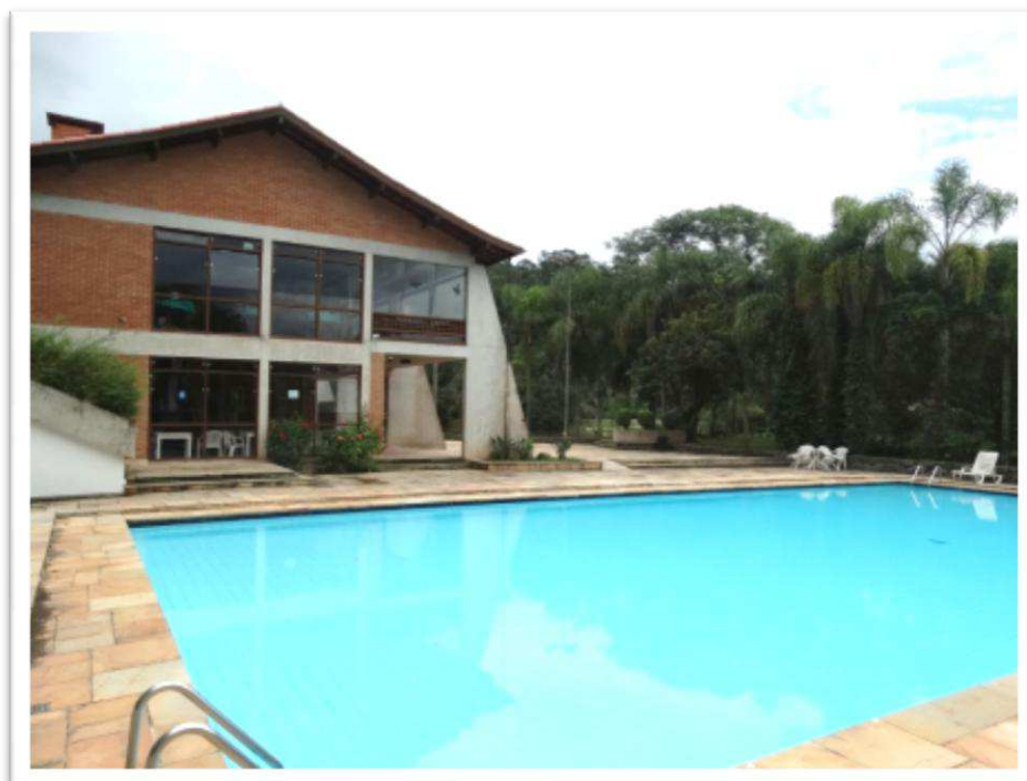
Foto nº 52 - Aspectos gerais do Residencial “GREEN VALLEY JARDIM ITATIAIA” – Piscina.
