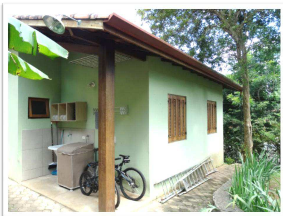
Foto nº 43 - Vista parcial do imóvel avaliando – Fachada lateral direita da Edificação 2.
