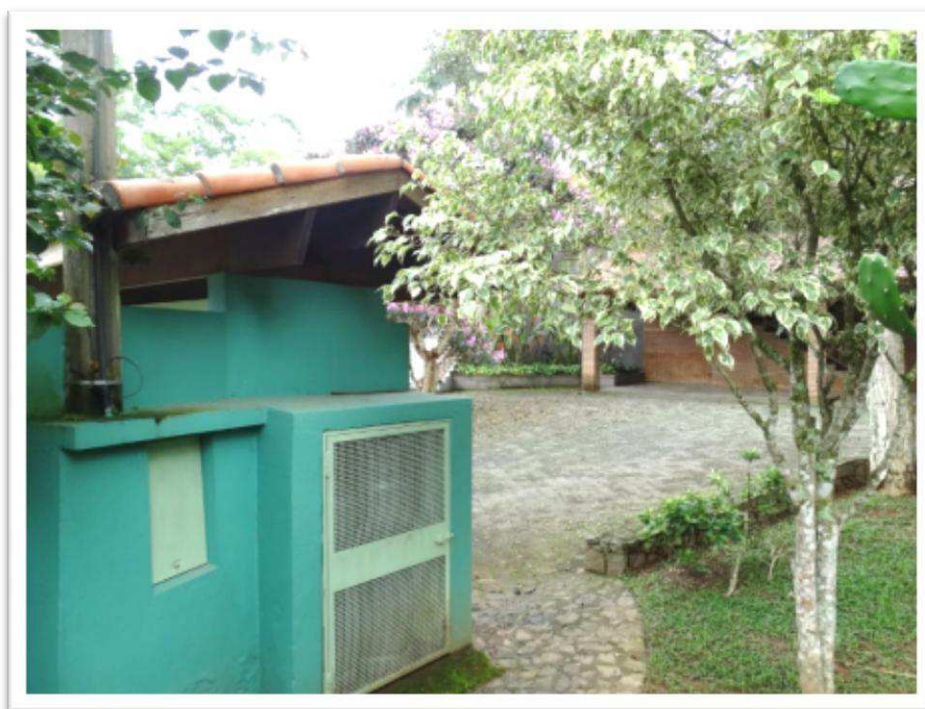
Foto nº 49 - Vista parcial do imóvel avaliando. Abrigos de gás e do medidor de energia elétrica.
