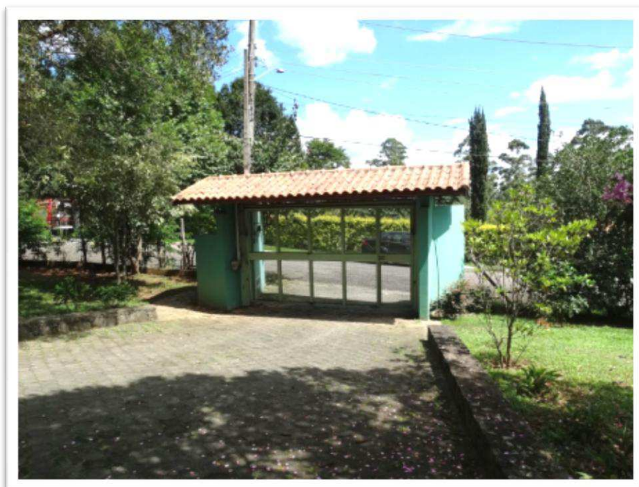
Foto nº 8 - Vista do portão de acesso ao imóvel avaliando, a partir de seu interior.
