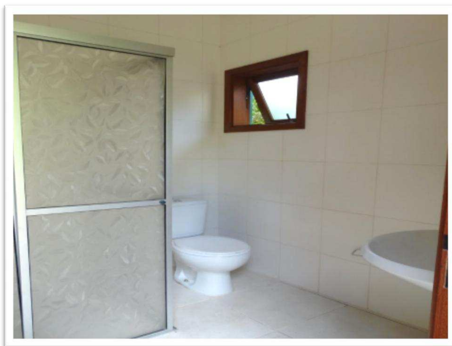
Foto nº 33 - Vista do banheiro existente na lateral direita do imóvel avaliando.
