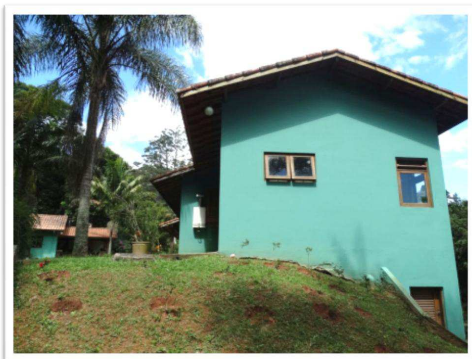
Foto nº 10 - Vista da fachada lateral esquerda do imóvel avaliando.
