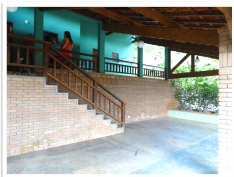
Foto nº 34 - Vista parcial da garagem do imóvel avaliando e da escada de acesso à área avarandada defronte à cozinha.
