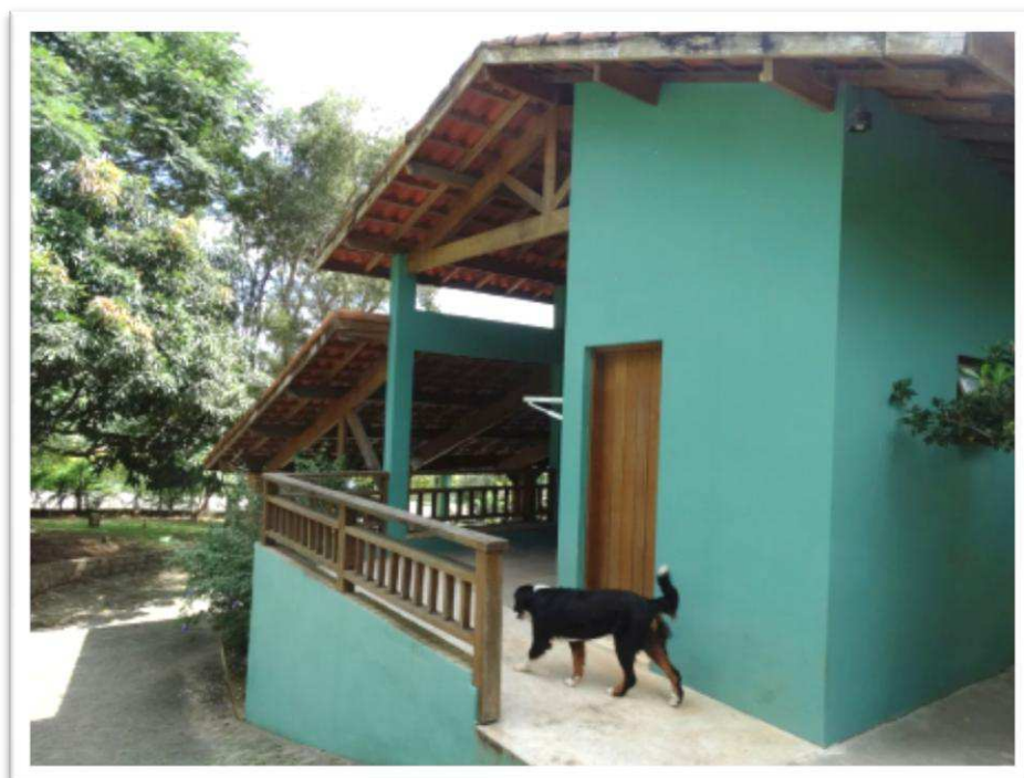
Foto nº 32 - Vista parcial da fachada lateral direita do imóvel avaliando – Porta de acesso ao banheiro.
