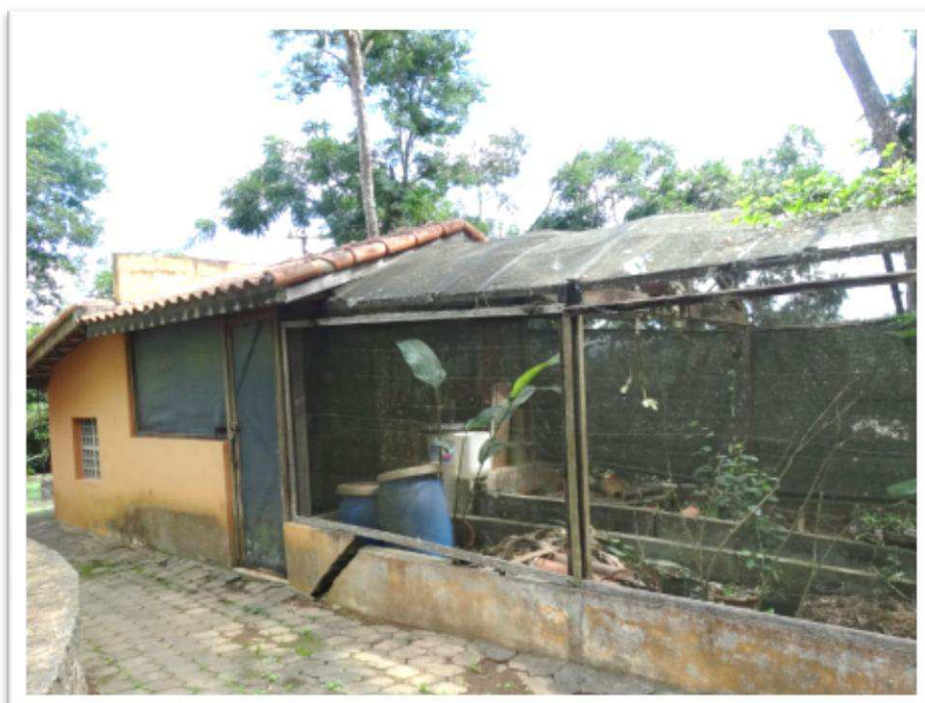
Foto nº 45 - Vista parcial do imóvel avaliando – Canil e área de depósito de materiais de jardinagem.
