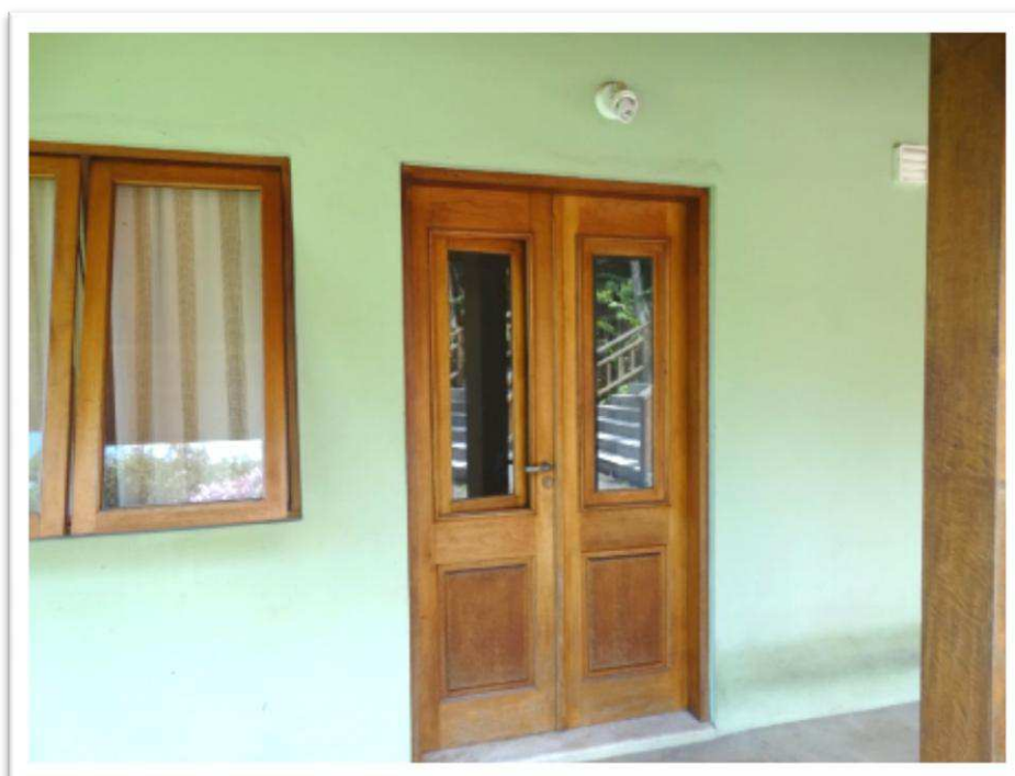
Foto nº 37 - Vista parcial do imóvel avaliando – Porta de acesso à Edificação 2, localizada defronte à Edificação 1 (corpo principal).
