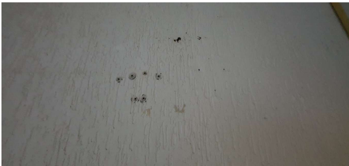
FOTO 13: SALA TÉRREO, FURAÇÕES NAS ALVENARIAS.
