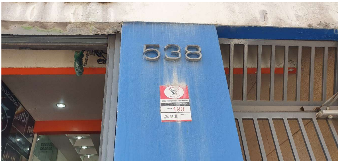
FOTO 05: DETALHE PARA NUMERAÇÃO 538 E A IDENTIFICAÇÃO DO PRÉDIO.
