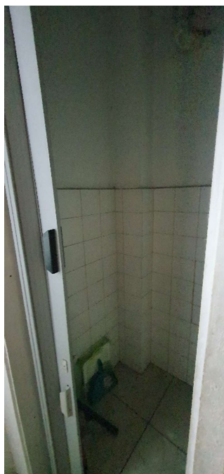
FOTO 25: VISTA DA ENTRADA DO BANHEIRO.
