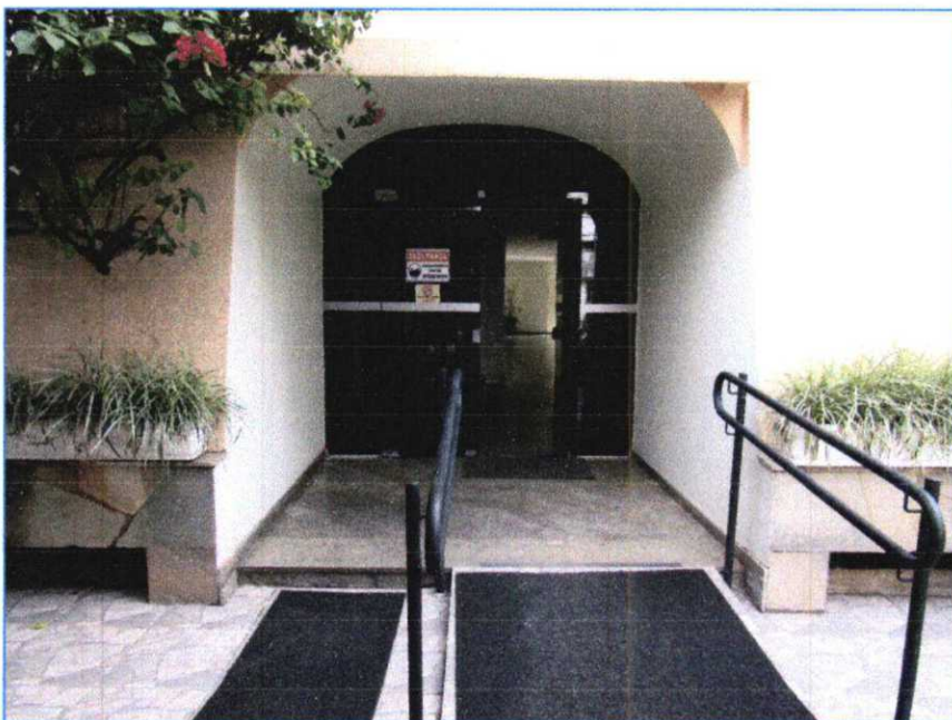
Foto de nº 30 - Acesso ao edifício.
