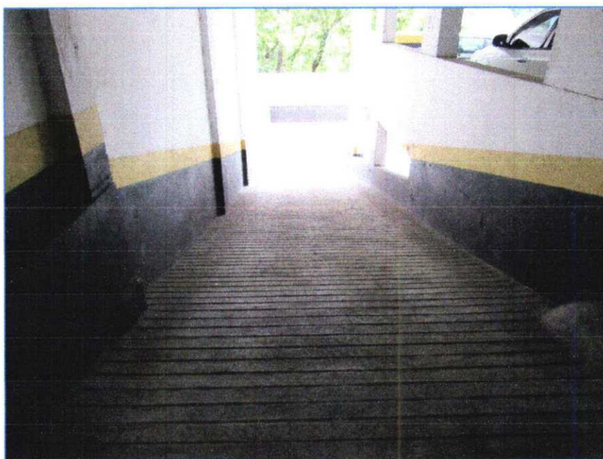
Foto de nº 10 - Sistema viário / acesso ao 3º subsolo.
