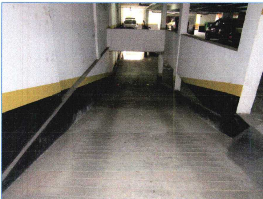
Foto de nº 08- Sistema viário / acesso ao 2º subsolo.
