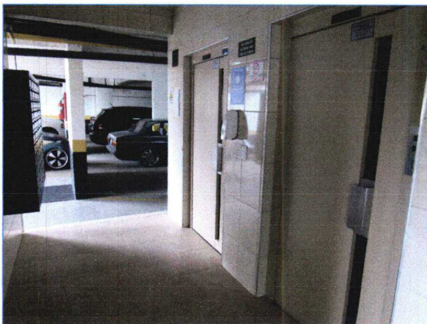
Foto de nº 35- Hall dos elevadores no subsolo.
