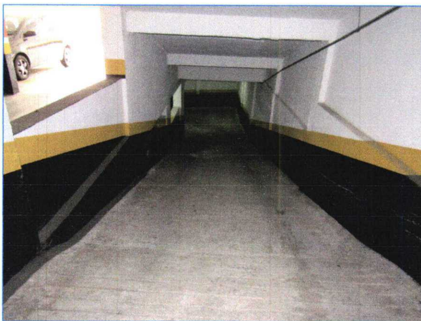
Foto de nº 13- Sistema viário / acesso ao 4º subsolo.
