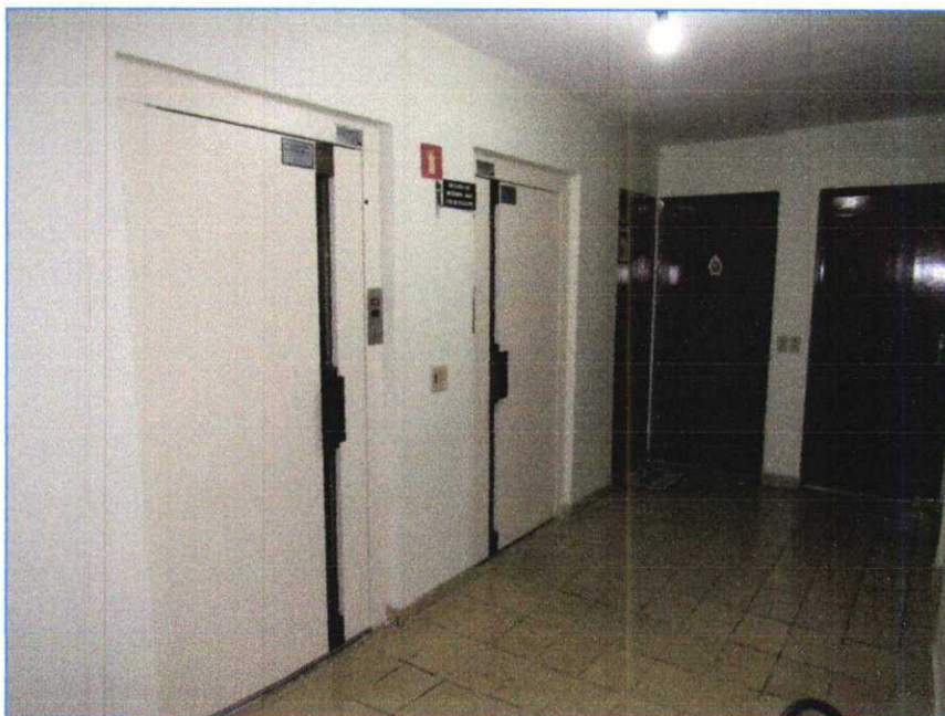
Foto de nº 37- Hall dos elevadores no 2º andar.
