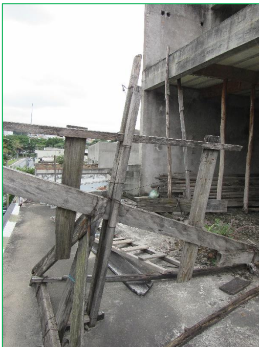
Aspectos gerais da edificação.
