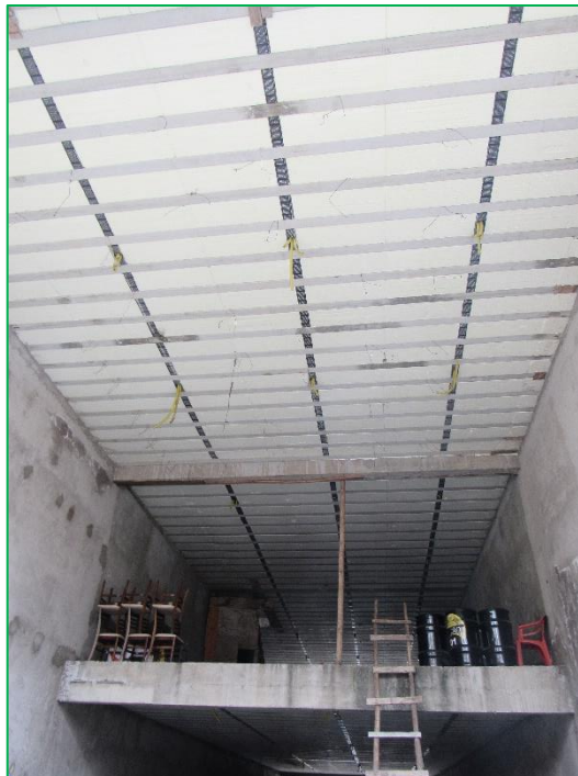
Aspectos gerais da edificação.
