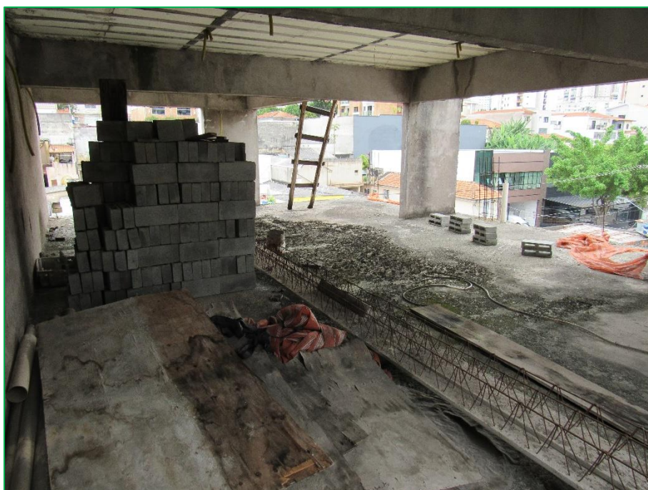
Aspectos gerais da edificação.
