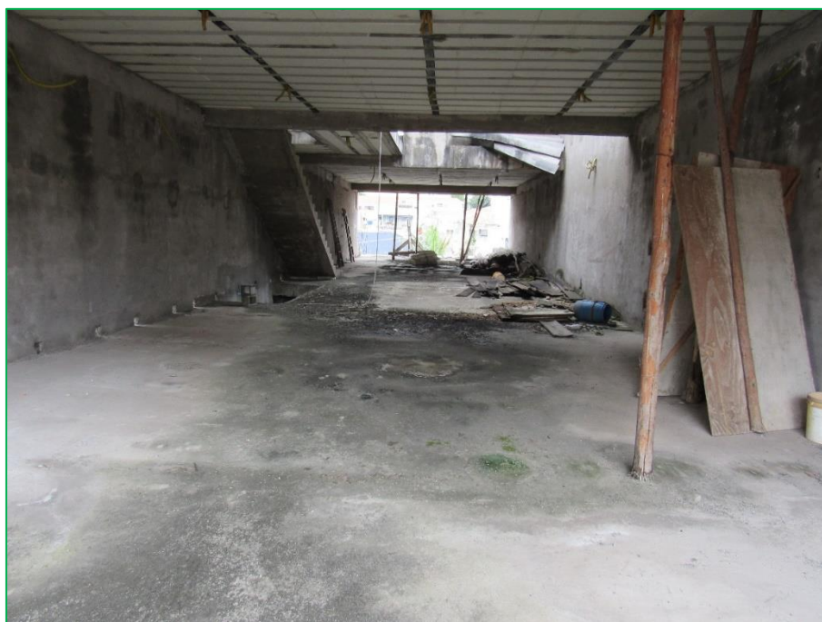
Aspectos gerais da edificação.
