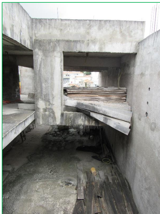
Aspectos gerais da edificação.
