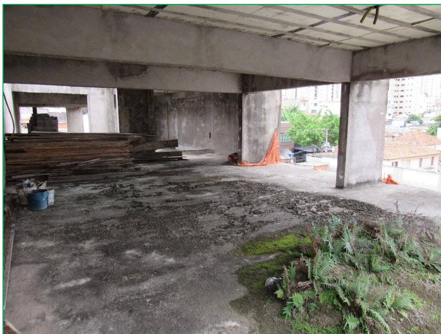
Aspectos gerais da edificação.
