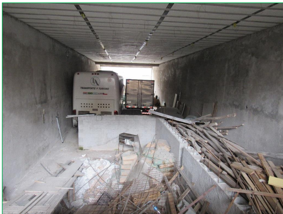
Aspectos gerais da edificação.
