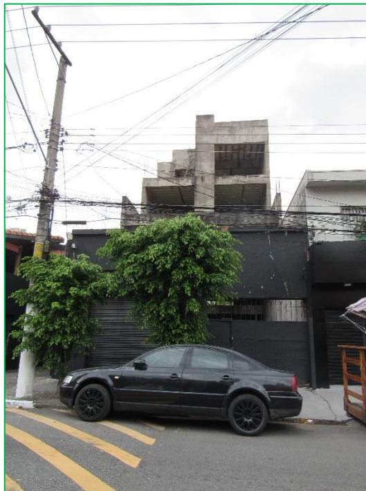
Fachada, em projeção para a Rua Marechal Barbacena.
