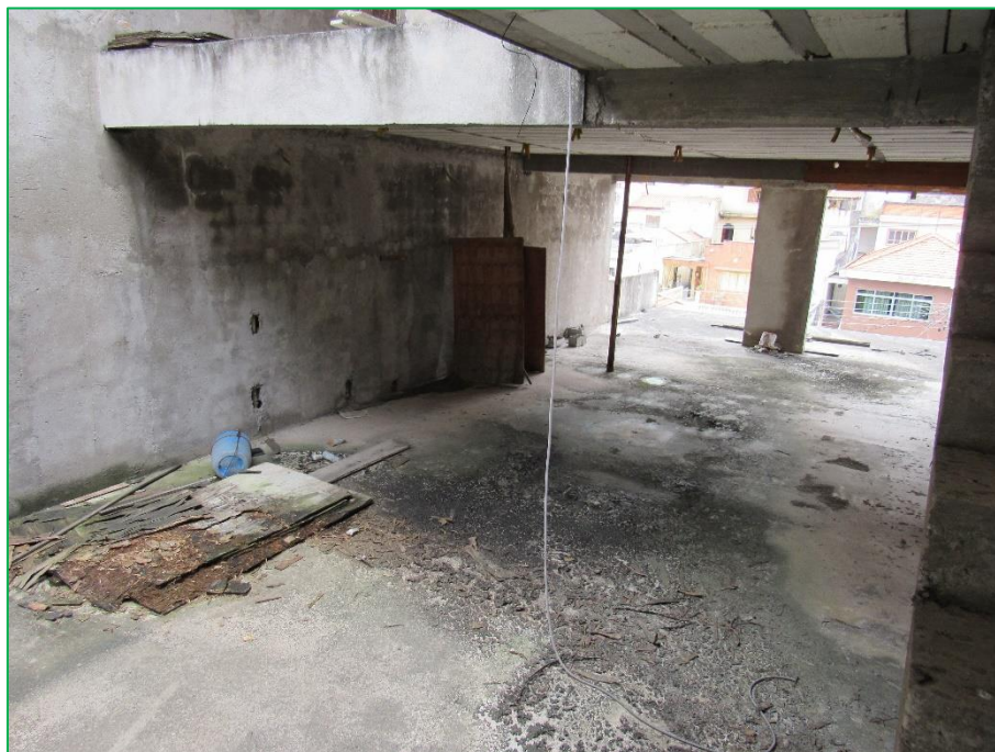
Aspectos gerais da edificação.
