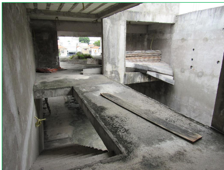
Aspectos gerais da edificação.
