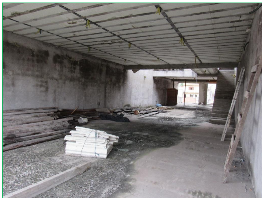
Aspectos gerais da edificação.
