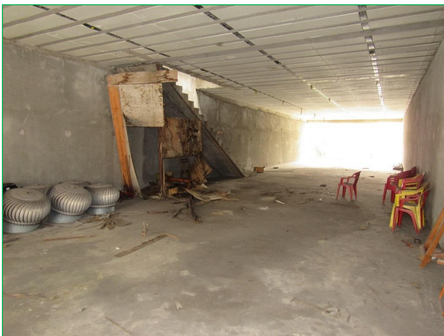
Aspectos gerais da edificação.
