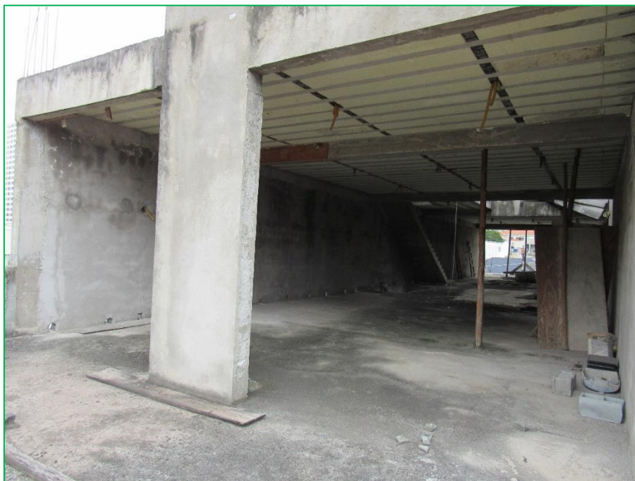
Aspectos gerais da edificação.
