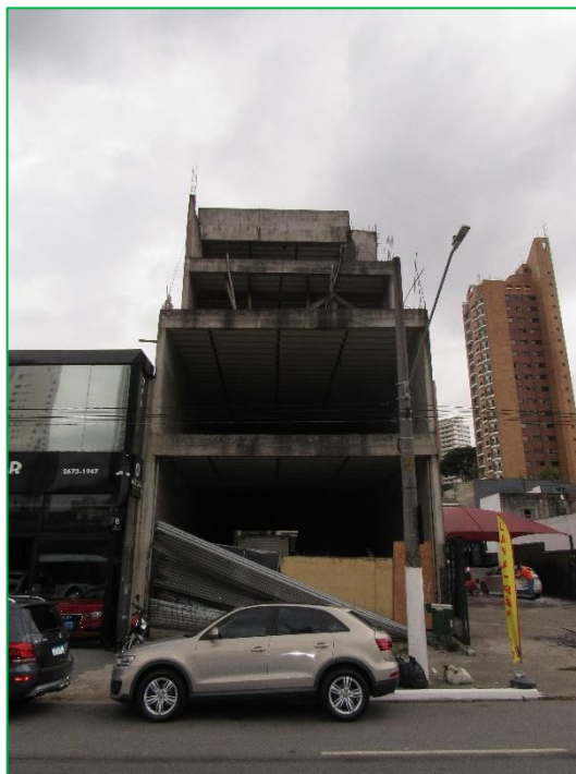
Fachada, em projeção para a Avenida Vereador Abel Ferreira.
