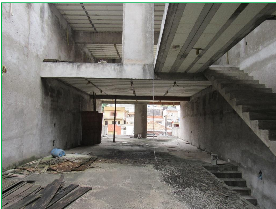
Aspectos gerais da edificação.
