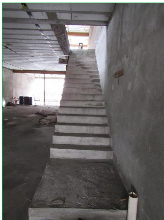
Aspectos gerais da edificação.
