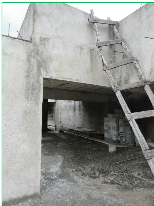
Aspectos gerais da edificação.
