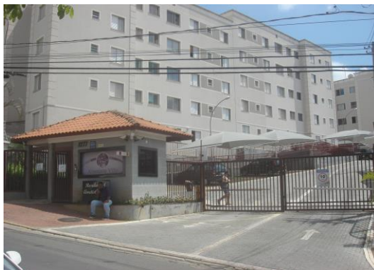
Vista do acesso ao Apartamento n º 504
