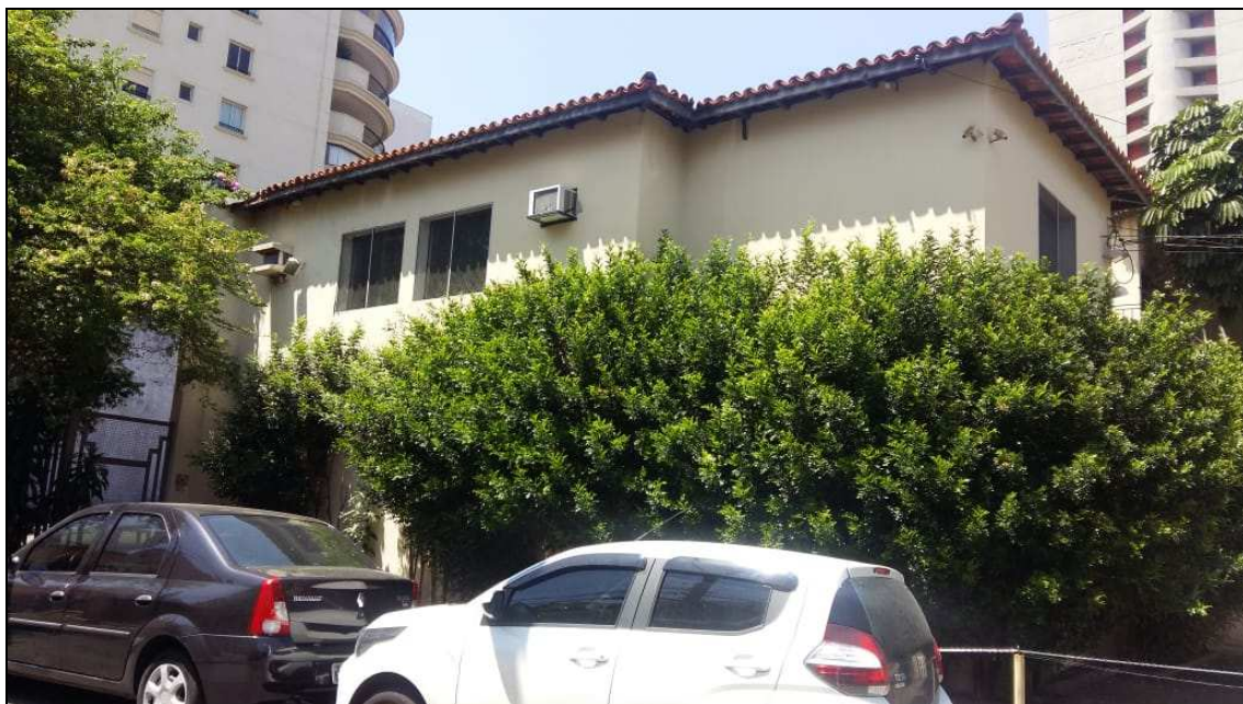
Figura 5 – Vista lateral do imóvel
