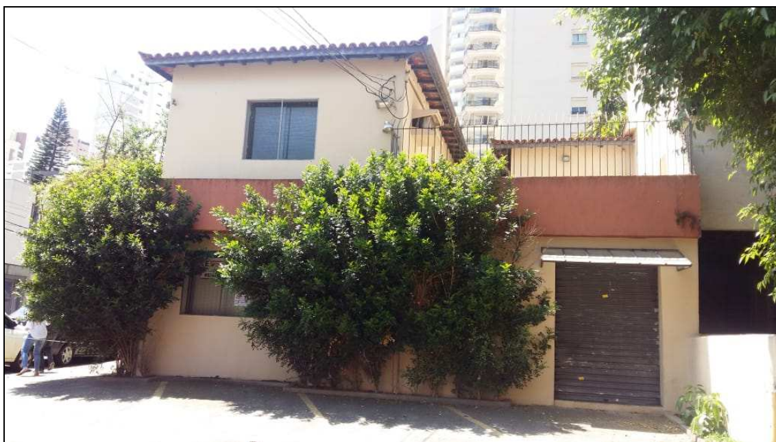
Figura 3 – Fachada do imóvel
