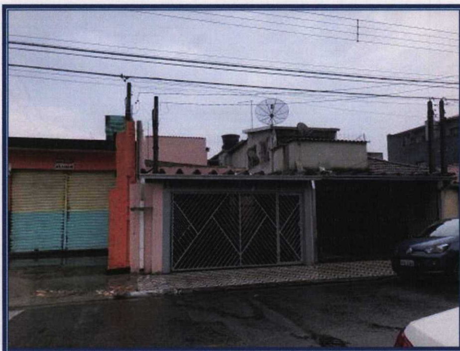
Vista da frente do imóvel avaliando.
