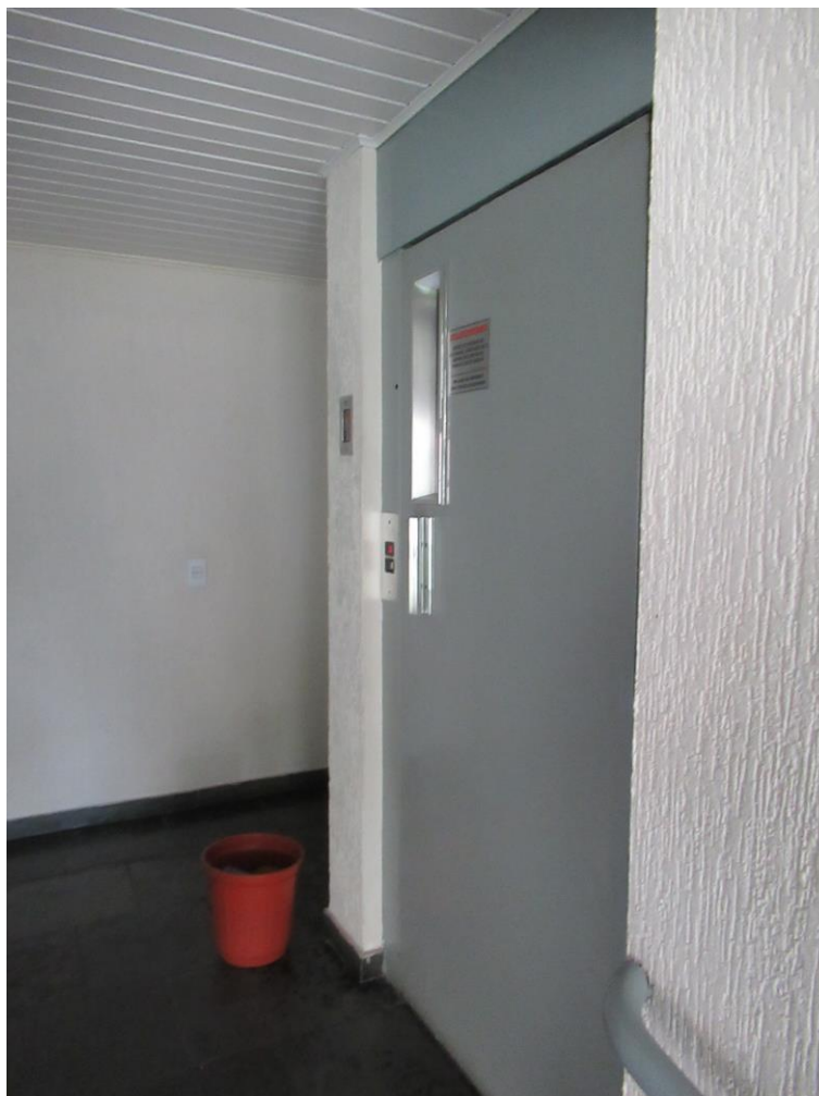
Foto nº. 10 – Vista do elevador localizado no hall social.
