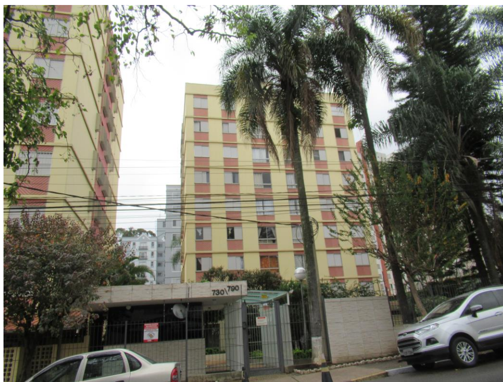
Foto nº. 2 – Vista da fachada do Residencial Santa Catarina.
