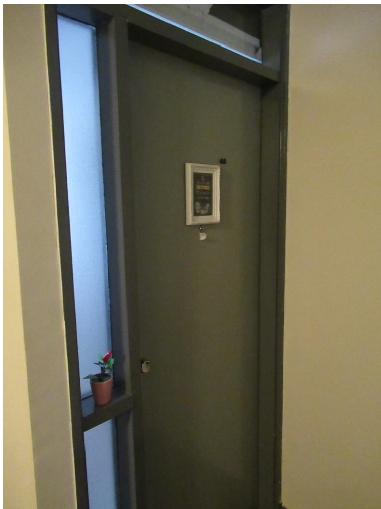
Foto nº. 12 – Vista da porta de entrada.
