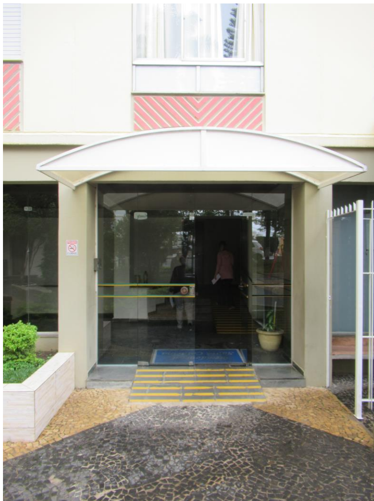
Foto nº. 8 – Vista da entrada do hall social.
