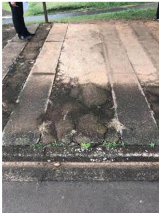
VISTA DA GARAGEM DO IMÓVEL.
