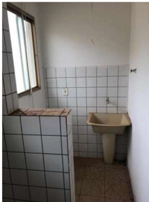
VISTA DA ÁREA DE SERVIÇO.
