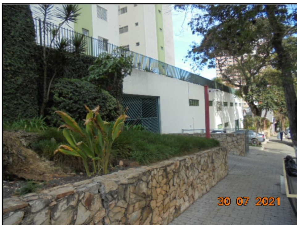
FOTO Nr.02: Fachada do estacionamento voltada para a Rua 28 de Setembro.
