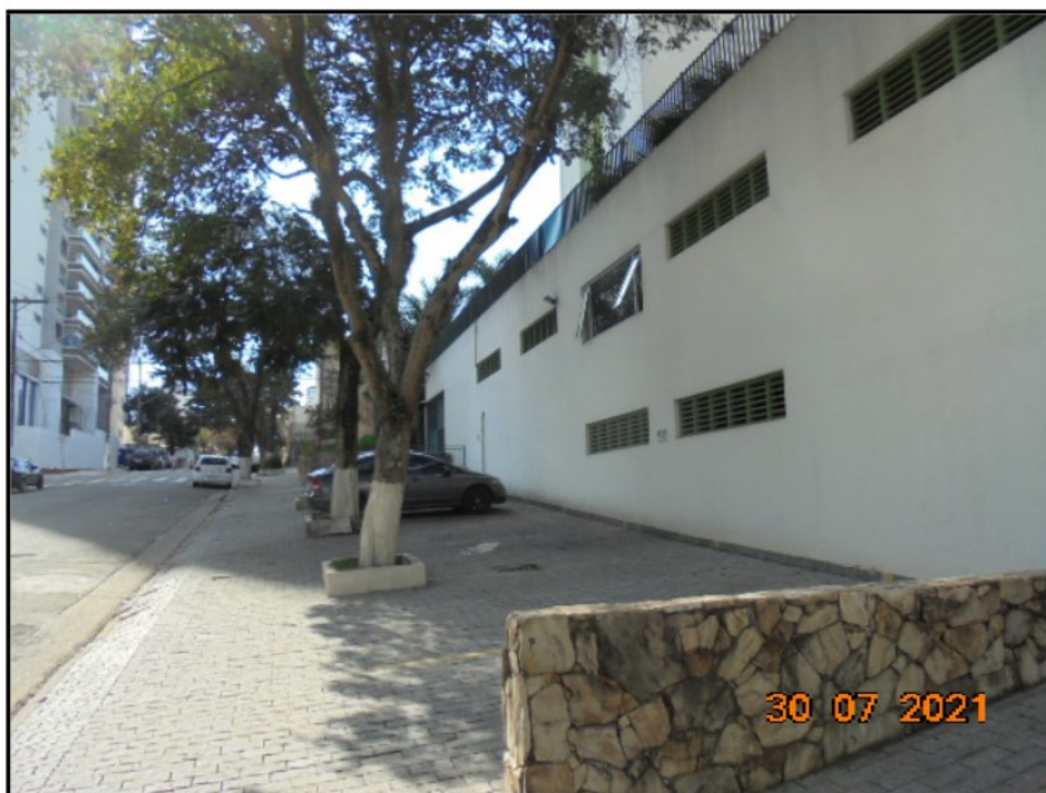
FOTO Nr.03: Fachada do estacionamento voltada para a Rua 28 de Setembro.
