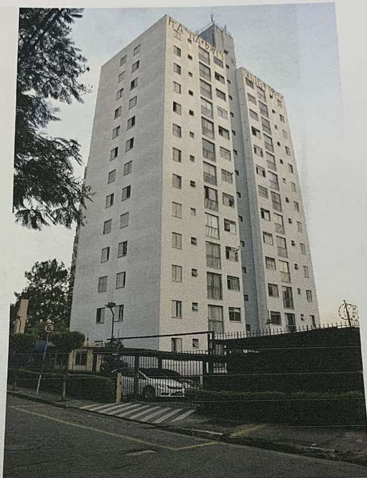
Foto 01 – Vista geral da fachada
