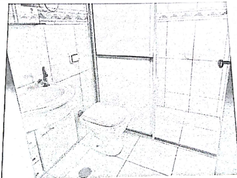
Foto 8 – Vista do banheiro da suíte.
