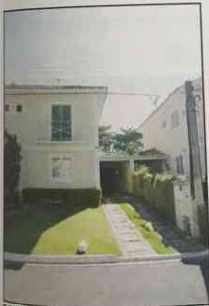
FOTO N.º 09- Tomada frontal do imóvel.
