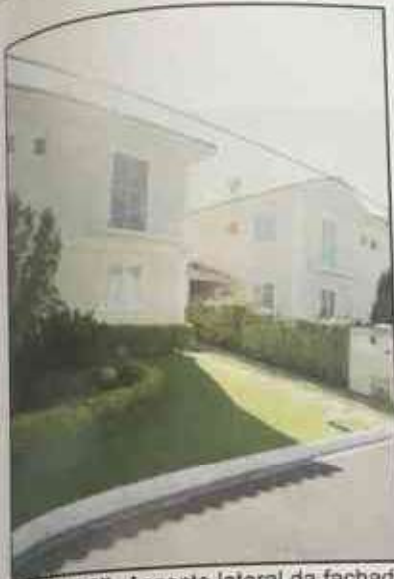
FOTO N.º 07- Aspecto lateral da fachada do imóvel
