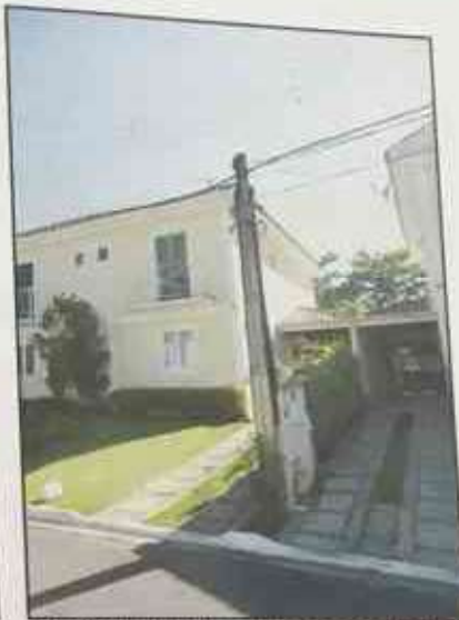
FOTO N.º 08- Vista lateral da fachada do imóvel
