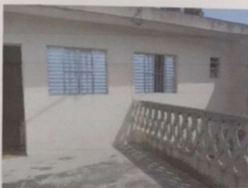
Terraço do segundo pavimento.
