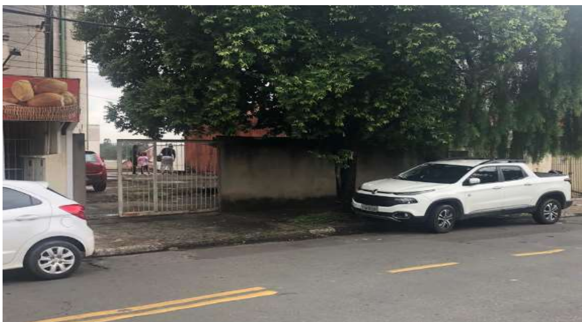
Imóvel residencial- Parque São Jorge
