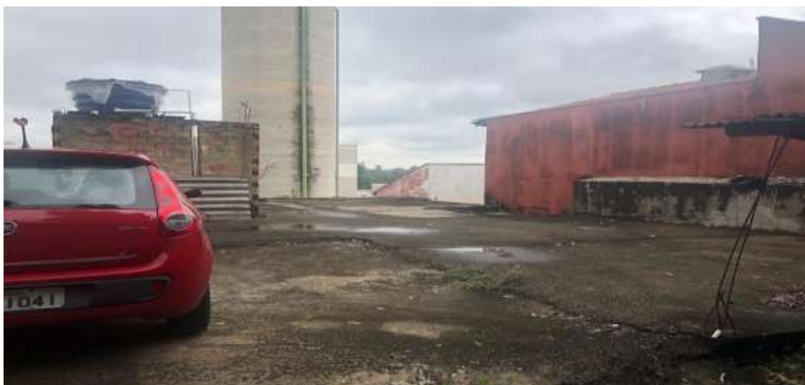
Imóvel ao nível da rua
