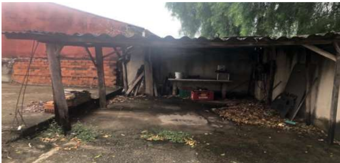
Cobertura utilizada como garagem
