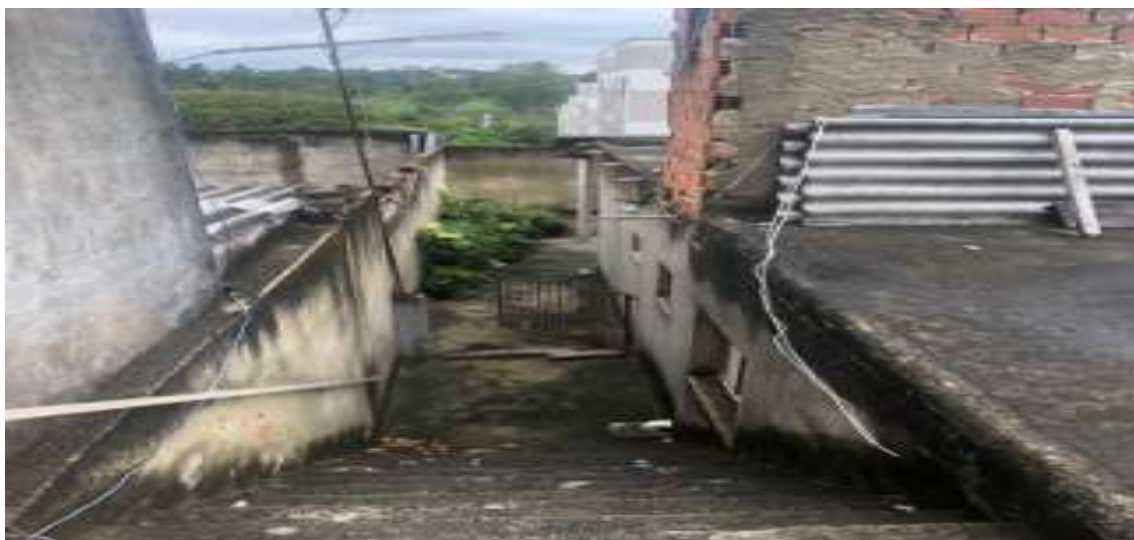
Escada de acesso a residência
