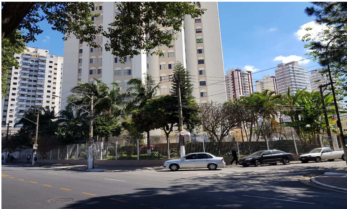
Foto 3 – Fachada lateral leste/oeste do condomínio
