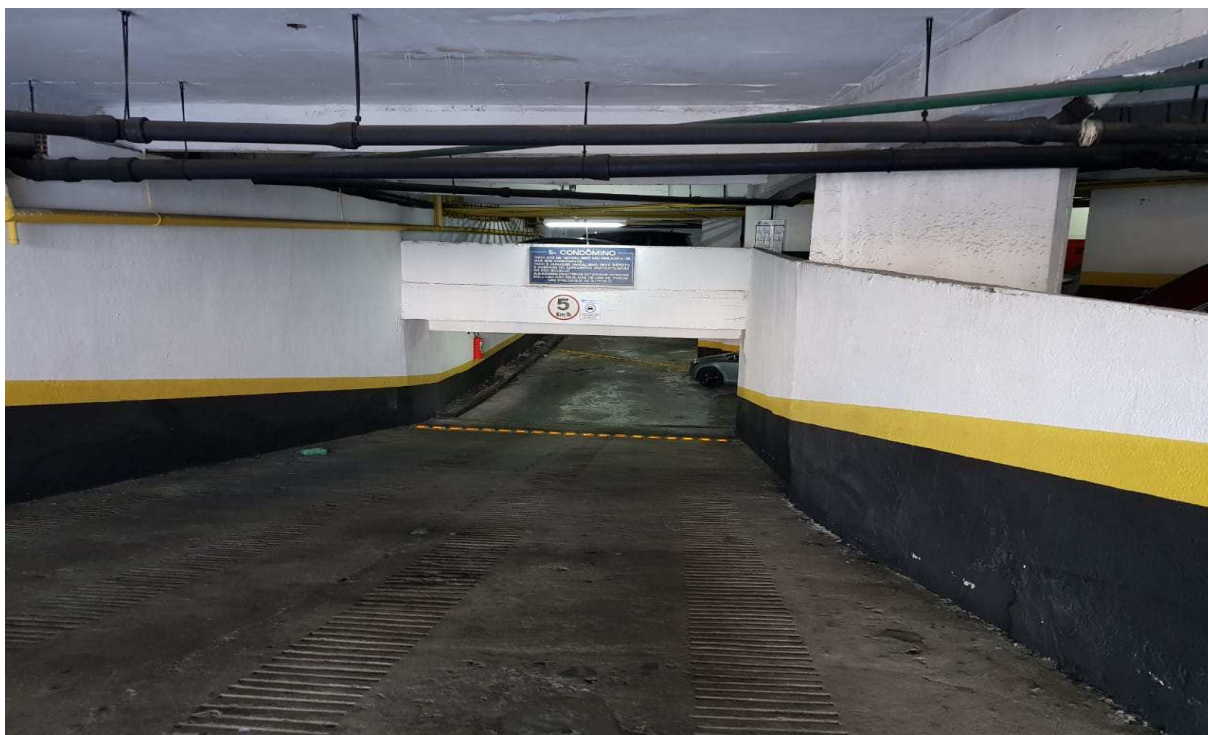
Foto 43 – Rampa de acesso ao 2º Subsolo
