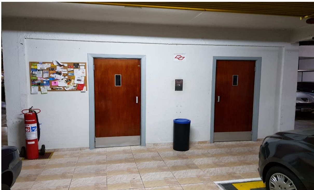
Foto 40 – Hall de elevadores do 1º Subsolo
