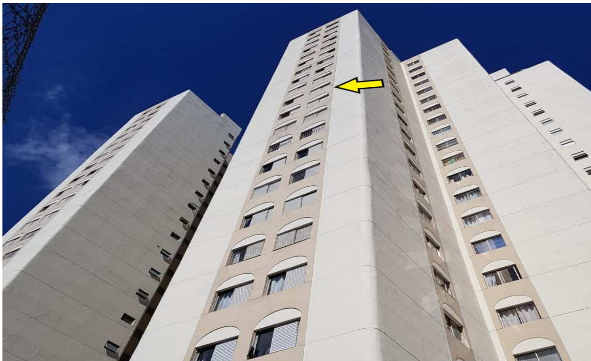
Foto 39 – Fachada posterior do Edifício Veneza (no detalhe, o apartamento 125)
