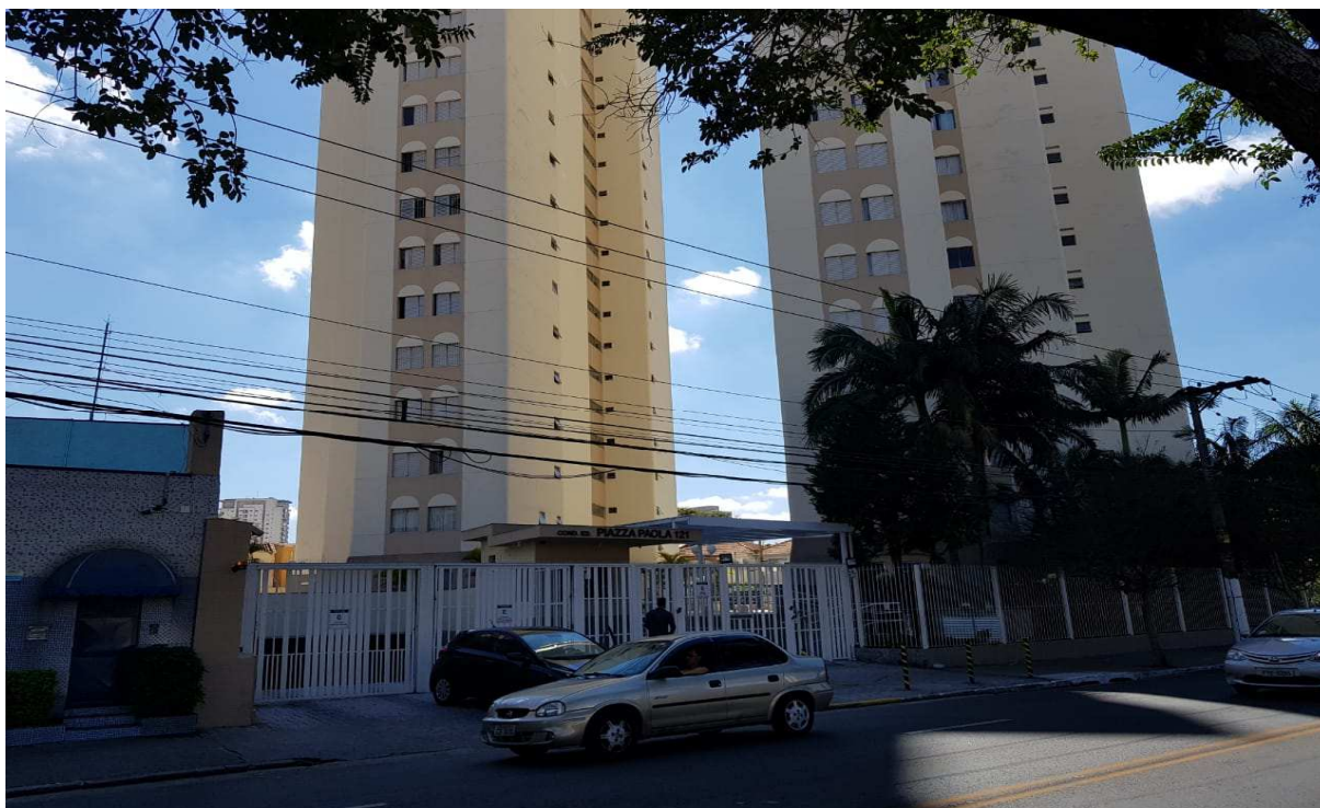
Foto 2 – Fachada frontal do condomínio
