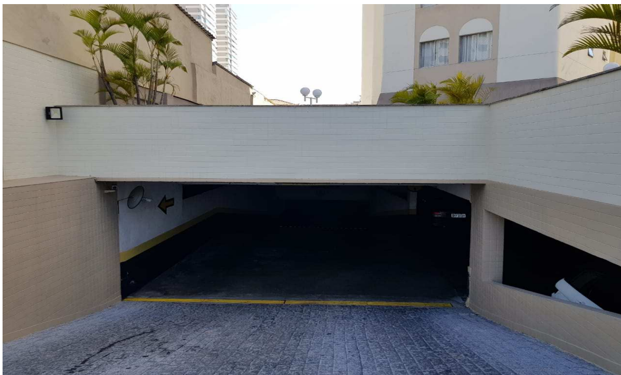
Foto 42 – Rampa de acesso ao 1º Subsolo
