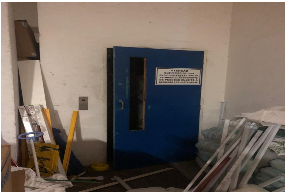
Elevador de cargas
