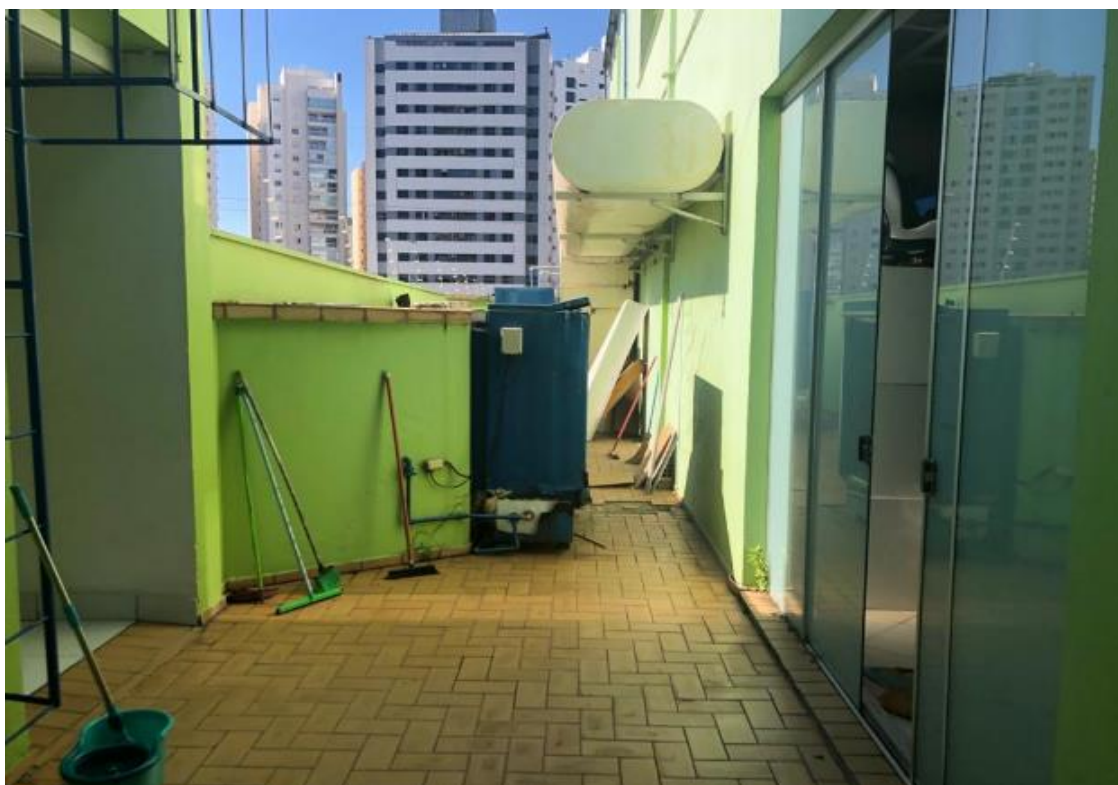
Visão externa da cobertura
