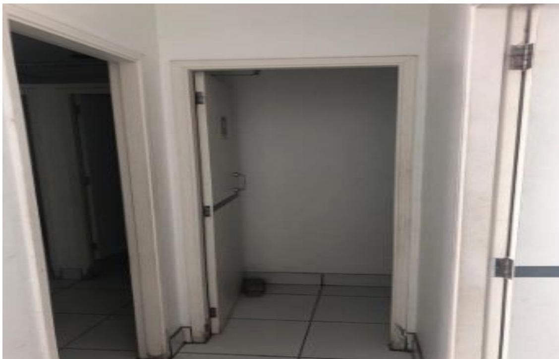
Banheiros dos funcionários
