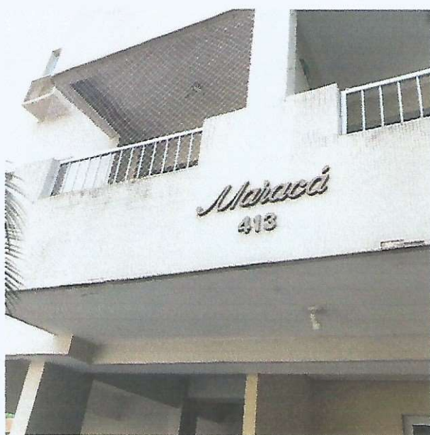
Figura 9 - Numeração e nomenclatura Edifício Maracá I.
