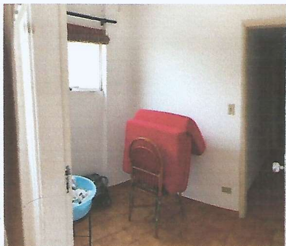
Figura 18 – Quarto de serviços.
