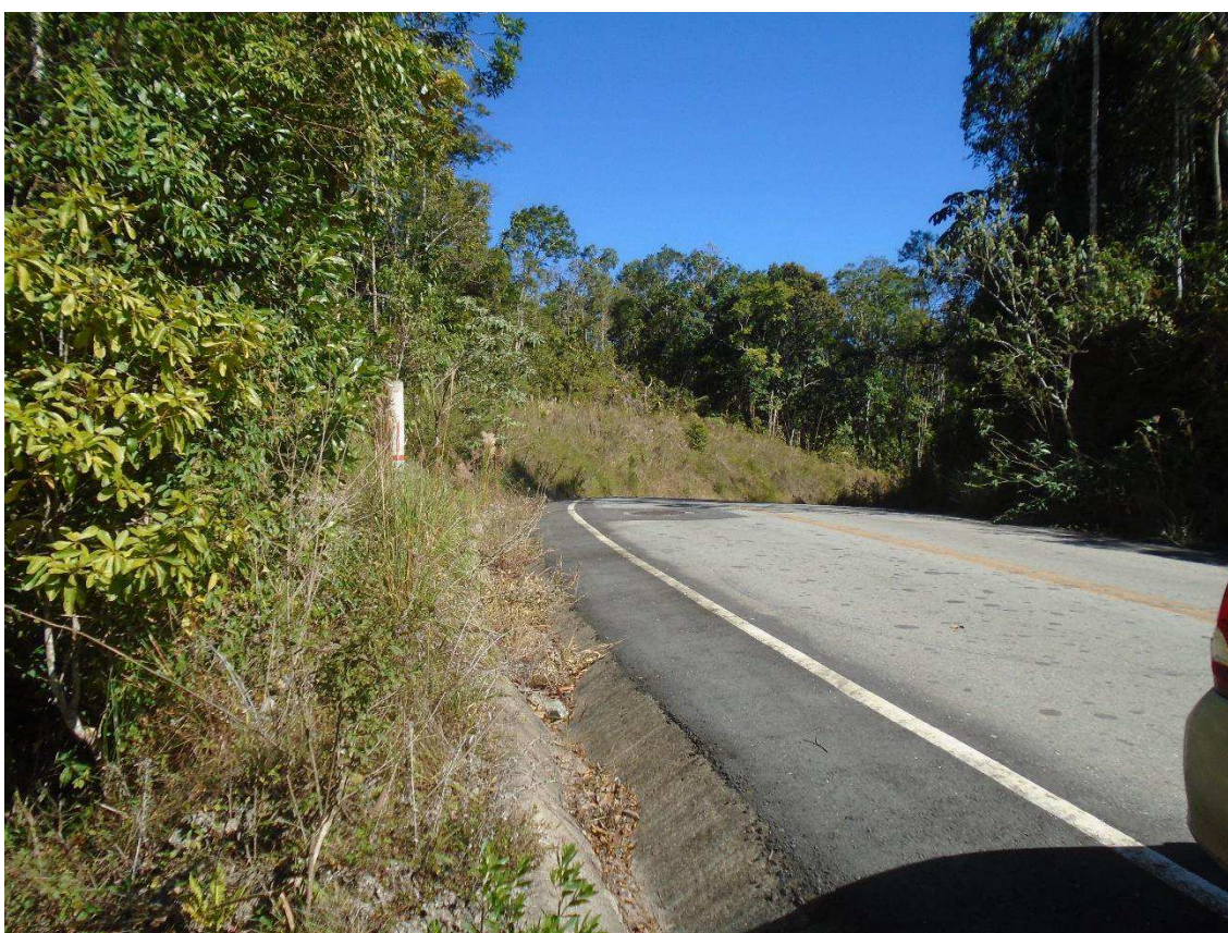
MAIS UM TRECHO DE DIVISA SECCIONADO PELA ESTRADA MUNICIPAL.
