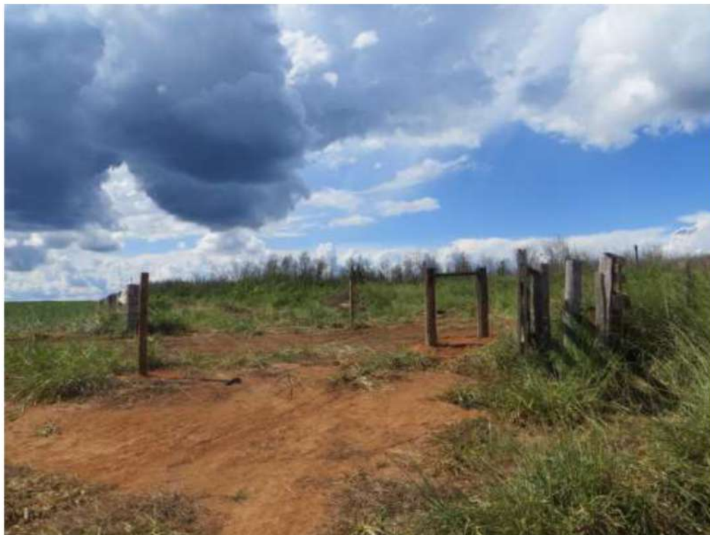
FOTO 4. No interior do imóvel, cercas novas, ainda em construção.
