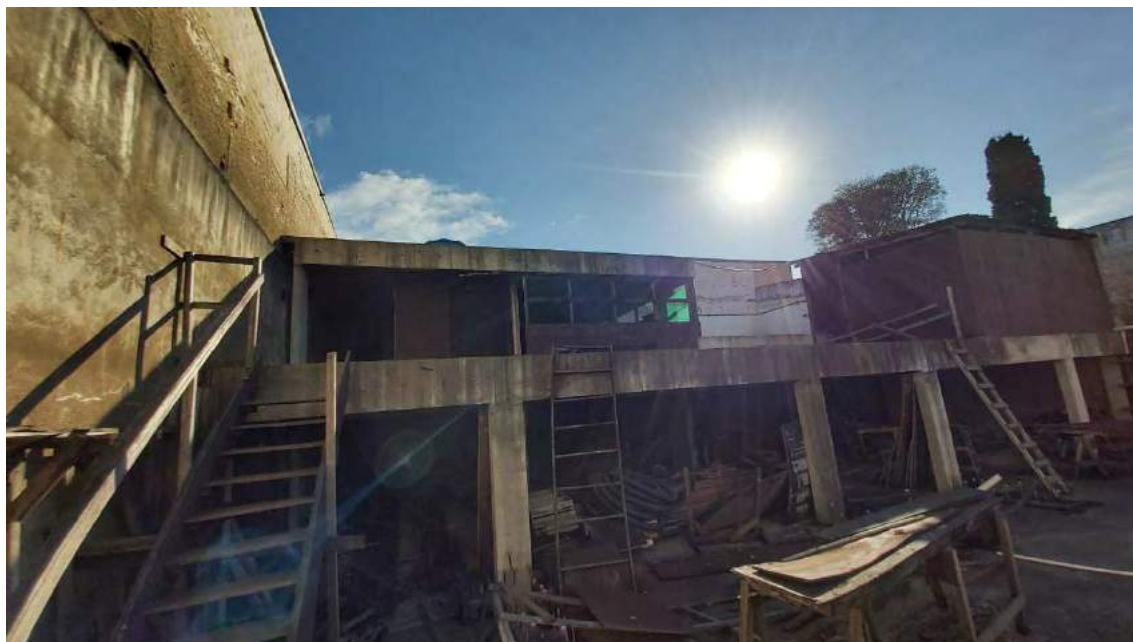
Vista de Edificação ao nível do 1º subsolo, acima do 2º subsolo.
