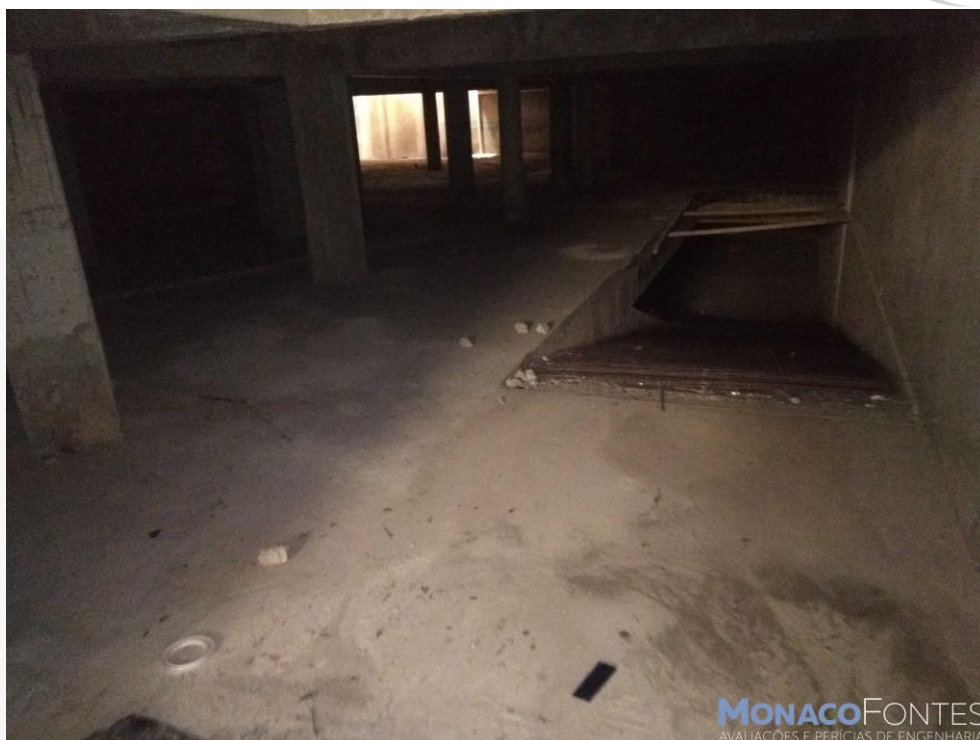
Acima, tem-se a demonstração da rampa de acesso ao subsolo e vagas de garagem.
