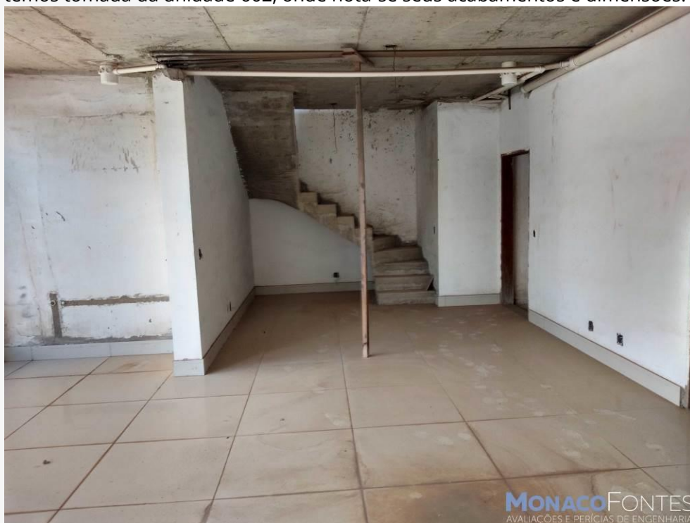
Acima temos tomada da unidade 602, onde nota-se seus acabamentos e dimensões.
