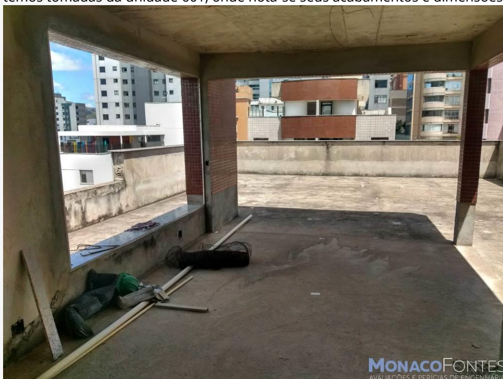
Acima temos tomada do terraço da unidade 601, onde nota-se seus acabamentos e dimensões.
