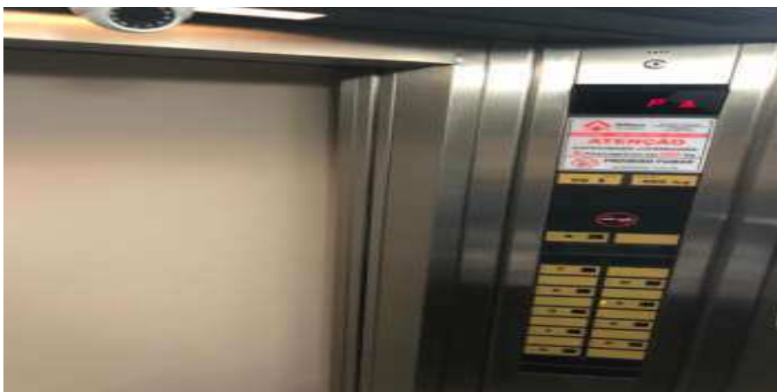
Visão interna do elevador
