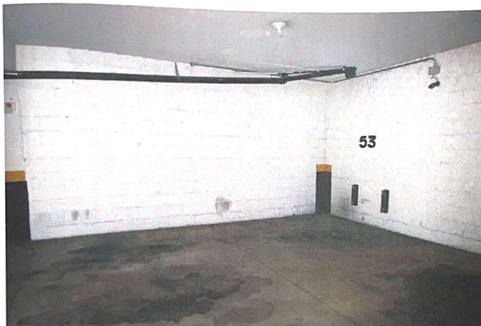
Foto nº 7: Outra vista da garagem nº 53 objeto da presente ação.
