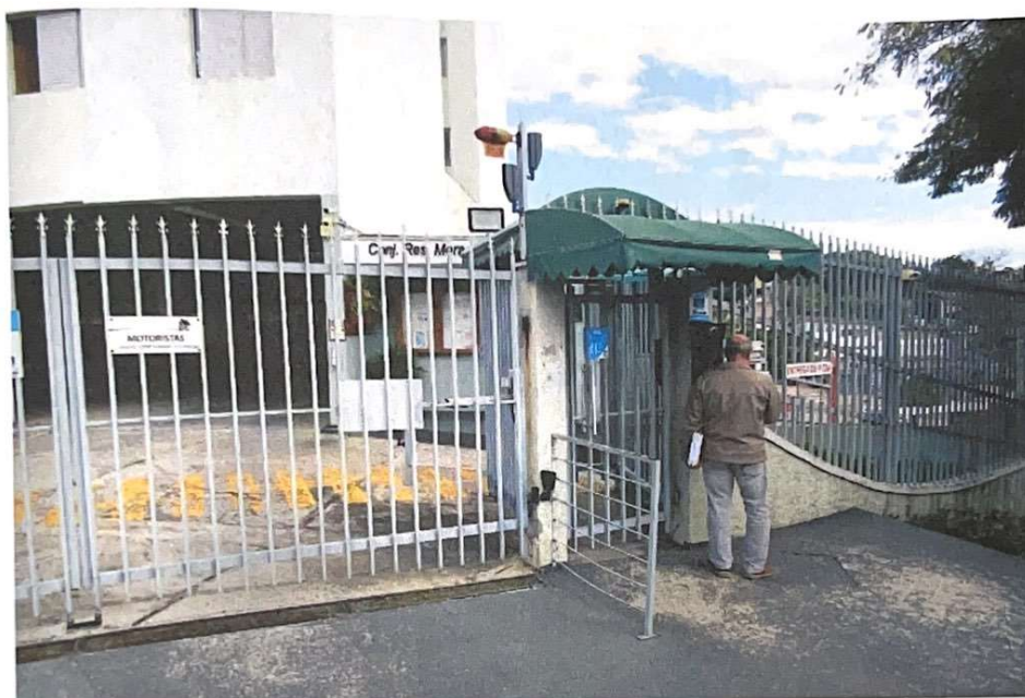
Foto nº 4: Vista do acesso para o interior do Condomínio.
