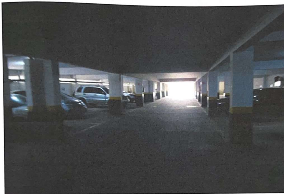
Foto nº 5: Vista geral da garagem localizada no subsolo do Conjunto Residencial Morada dos Imigrantes.
