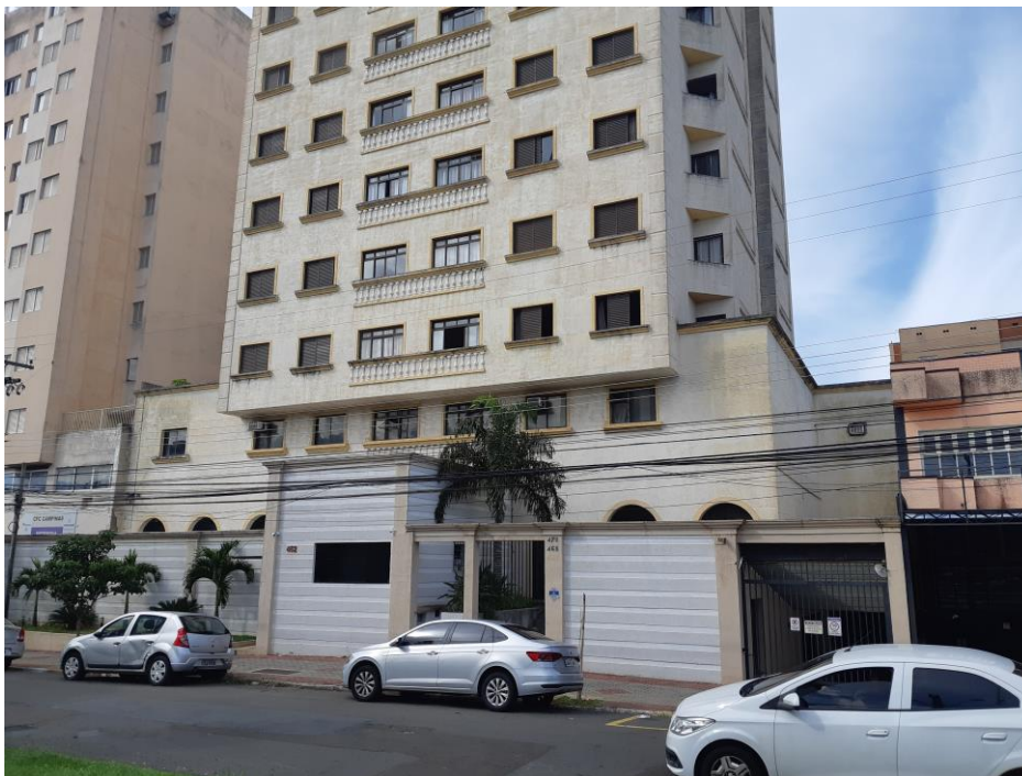
Detalhe da fachada do edifício.
