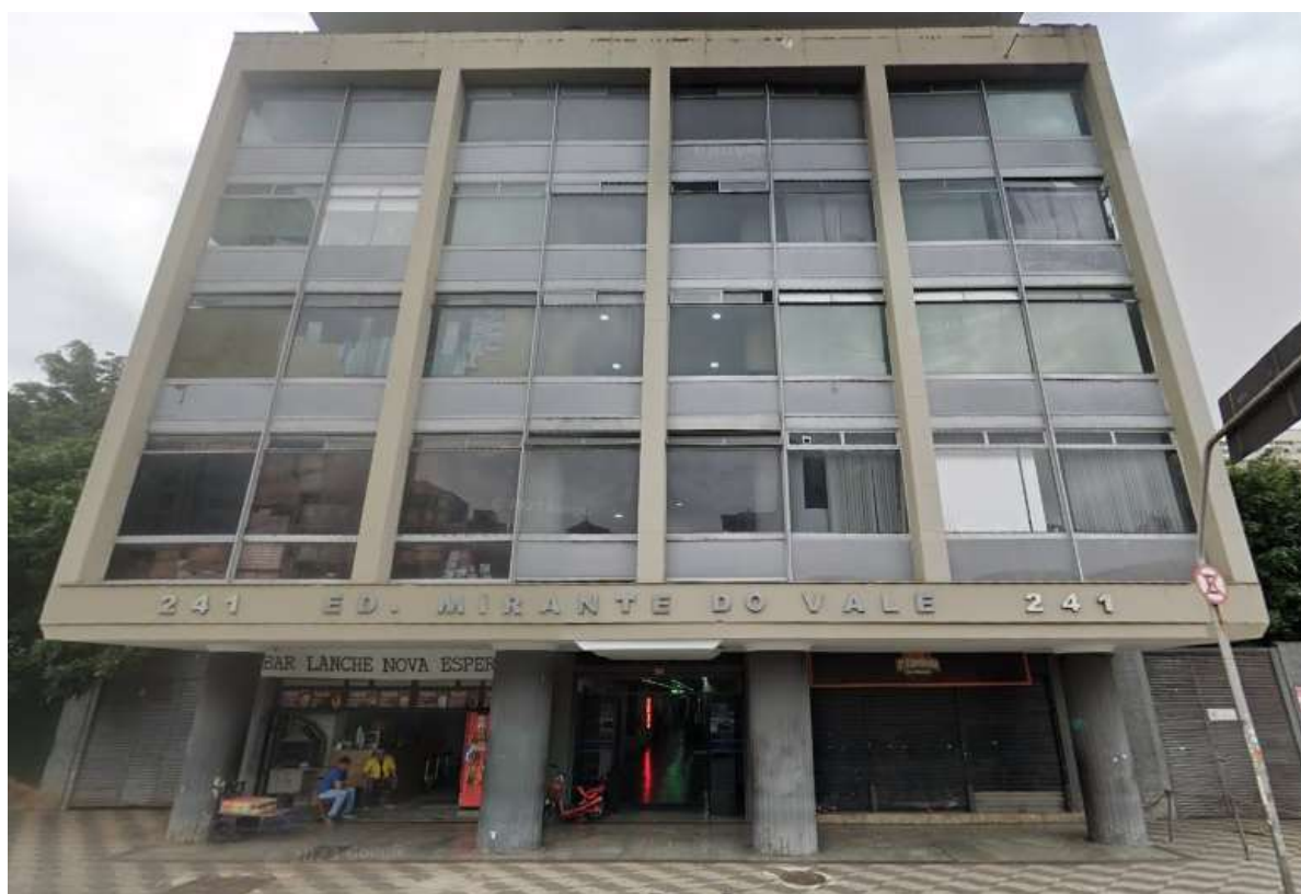
FIGURA 1: VISTA DA ENTRADA DO IMÓVEL AVALIANDO.
