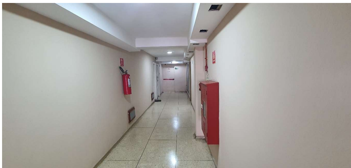
FOTO 15: NO HALL DO PAVIMENTO, VISTA PARA A SAÍDA DA ESCADA.
