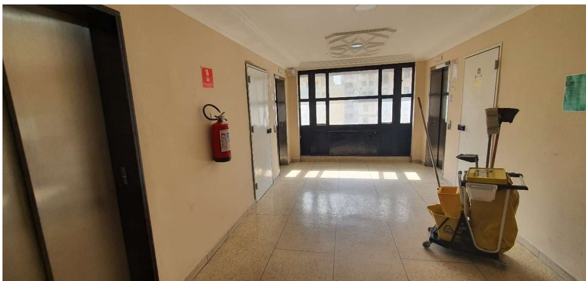
FOTO 12: HALL DE ACESSO DOS PAVIMENTOS 14 E 15.
