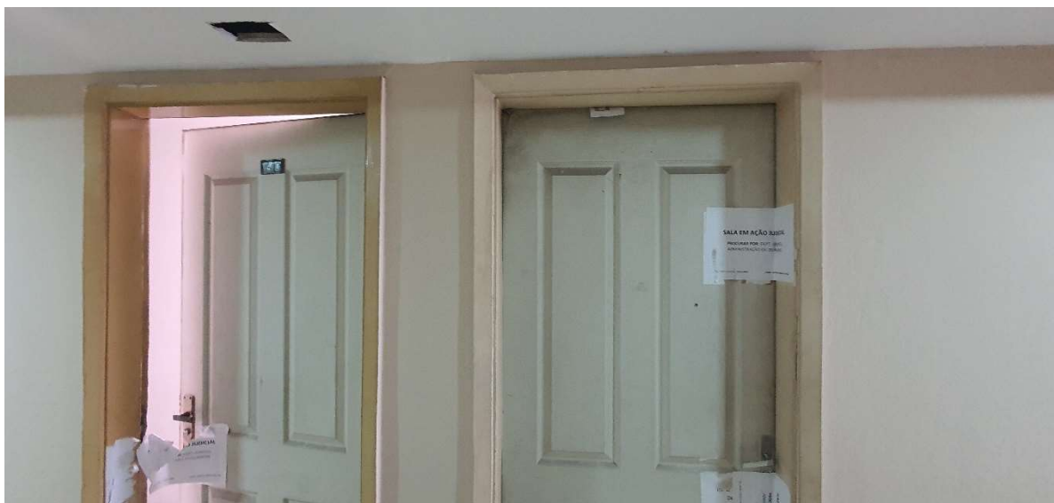
FOTO 17: VISTA DAS PORTAS DE ACESSO DAS UNIDADES.
