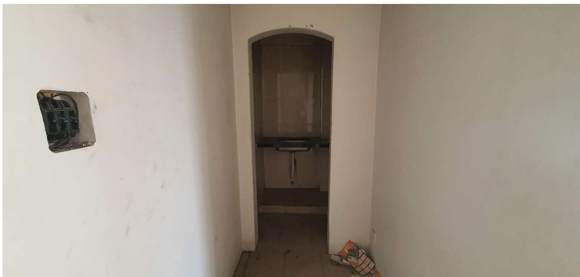
FOTO 23: VISTA DA ENTRADA DO LAVATÓRIO 1.
