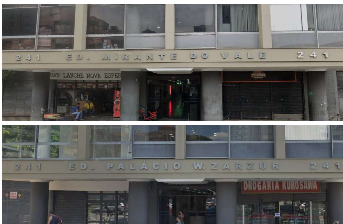
FOTO 06: PLACA DE IDENTIFICAÇÃO DO EDIFÍCIO, FOI ALTERADA COM O TEMPO.
