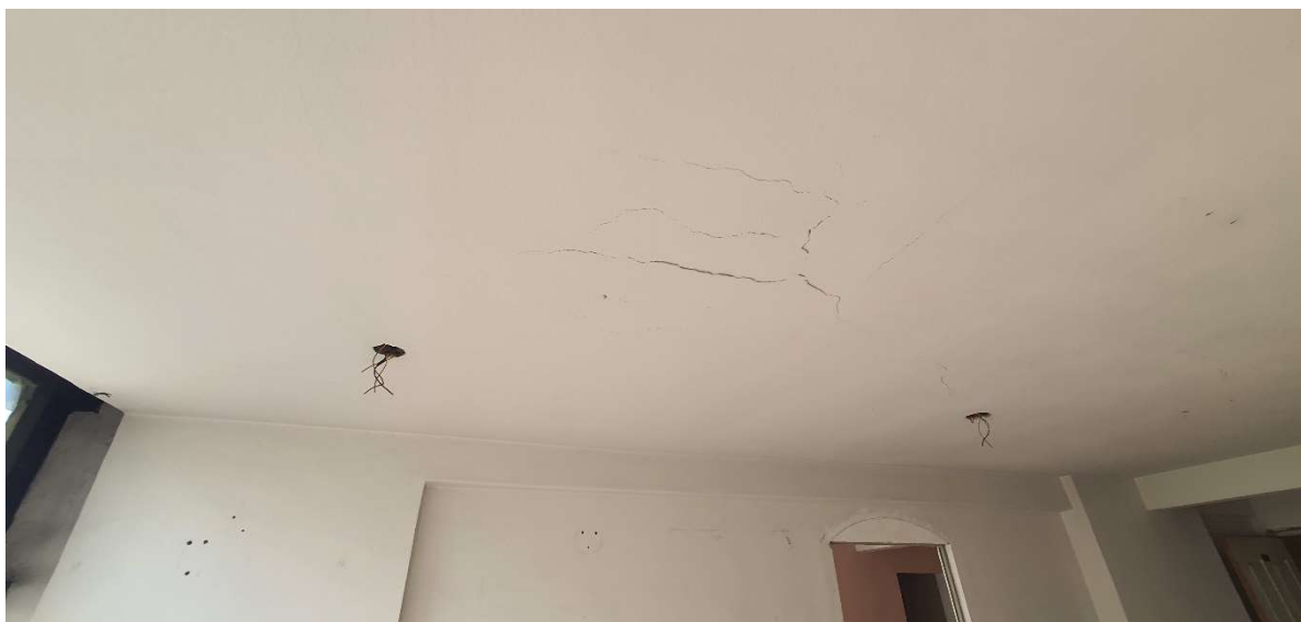
FOTO 29: NA SALA 1, FALTAM AS LUMINÁRIAS, TETO COM FISSURAS.
