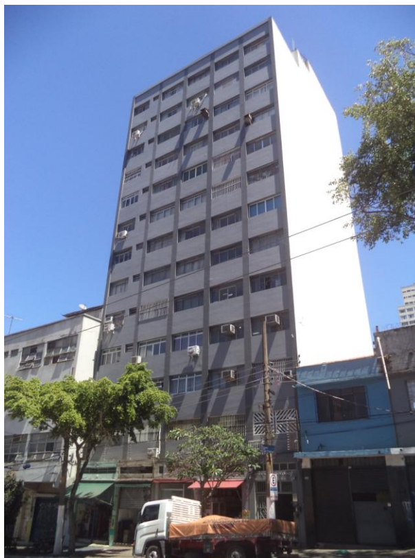
Vista parcial da fachada do edifício
