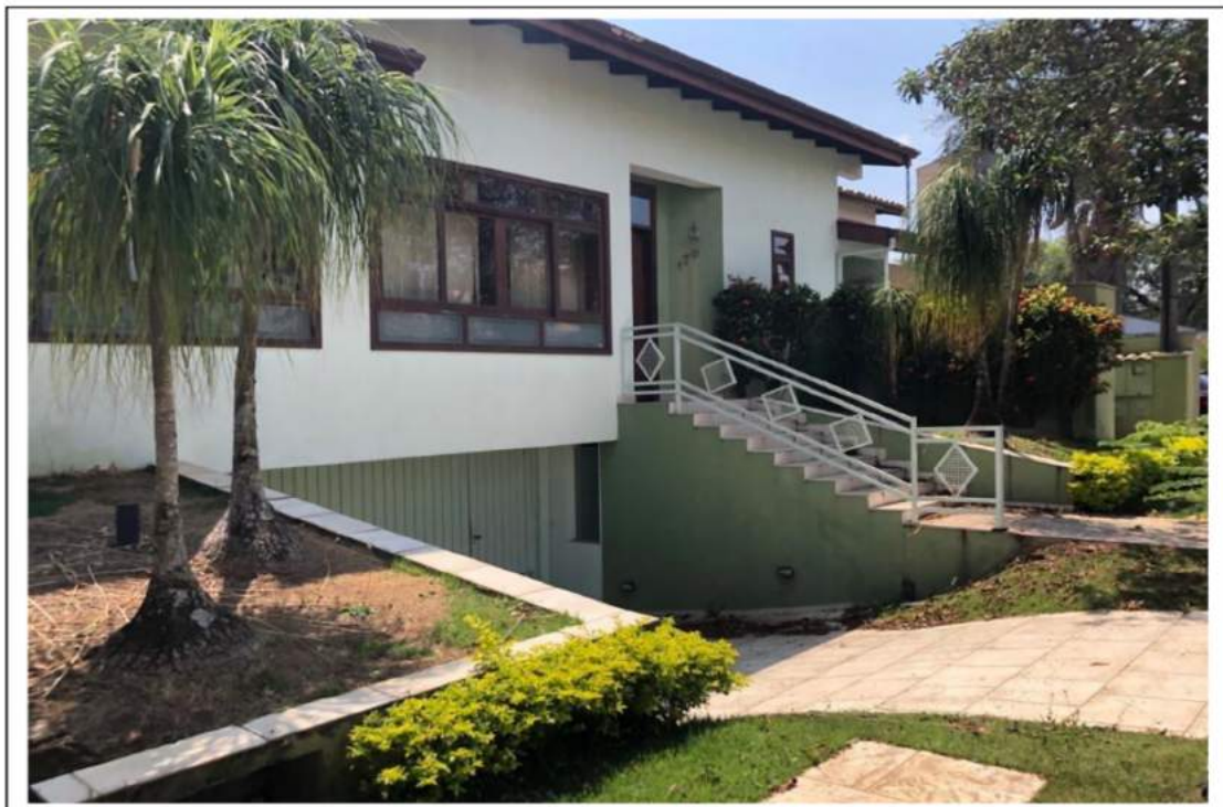
Foto 06: Vista do Lote de terreno nº 17 da Quadra X do Loteamento Portal do Paraíso – 1ª Etapa onde há uma construção erigida em alvenaria sob nº 170.
