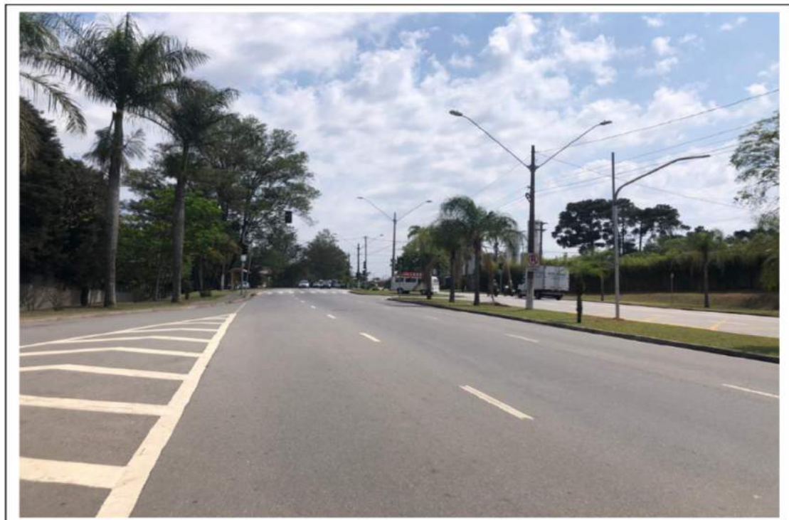
Foto 02: Outra vista da Rodovia Vereador Geraldo Dias. O observador encontra-se no mesmo local da foto anterior, dessa vez olhando em direção oposta.
