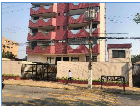
Foto 9 – Vista da fachada frontal
