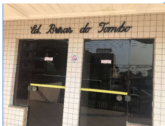
Foto 10 – Vista da fachada frontal
