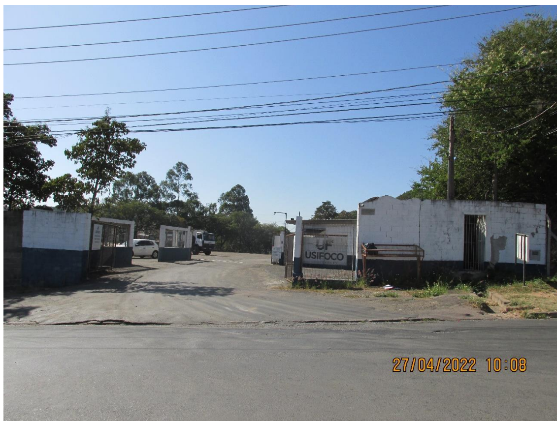
Fachada Imóvel Periciando
