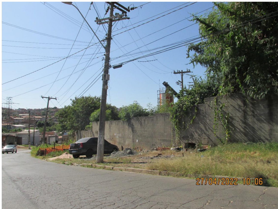
Fachada Imóvel Periciando
