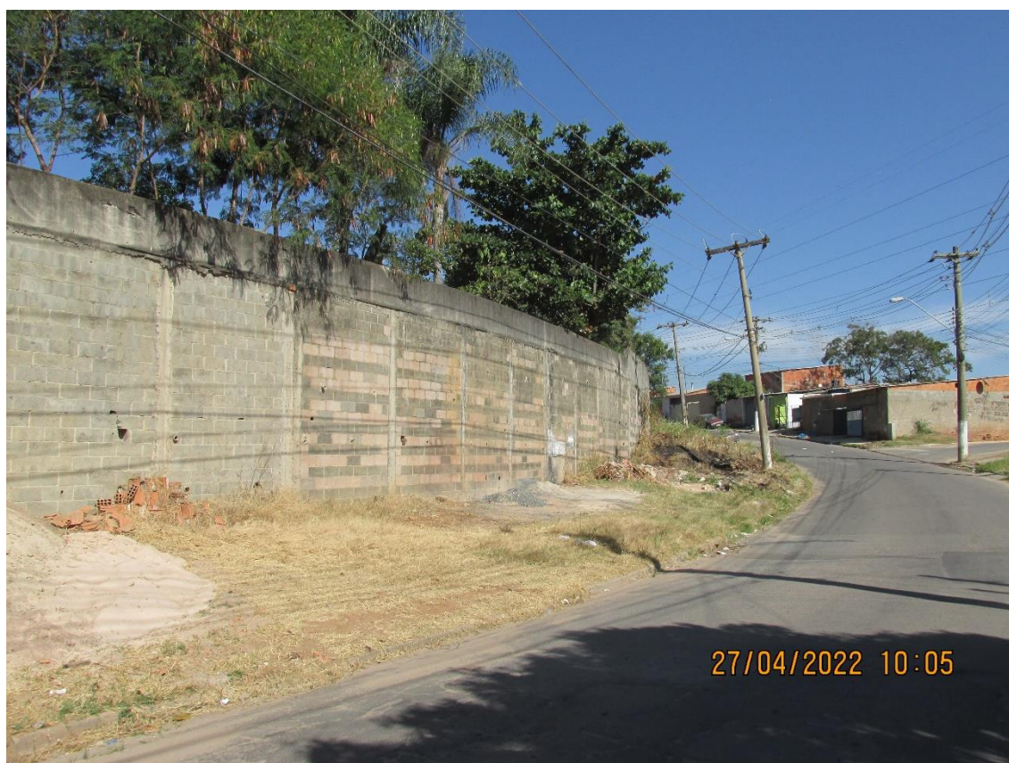
Fachada Imóvel Periciando
