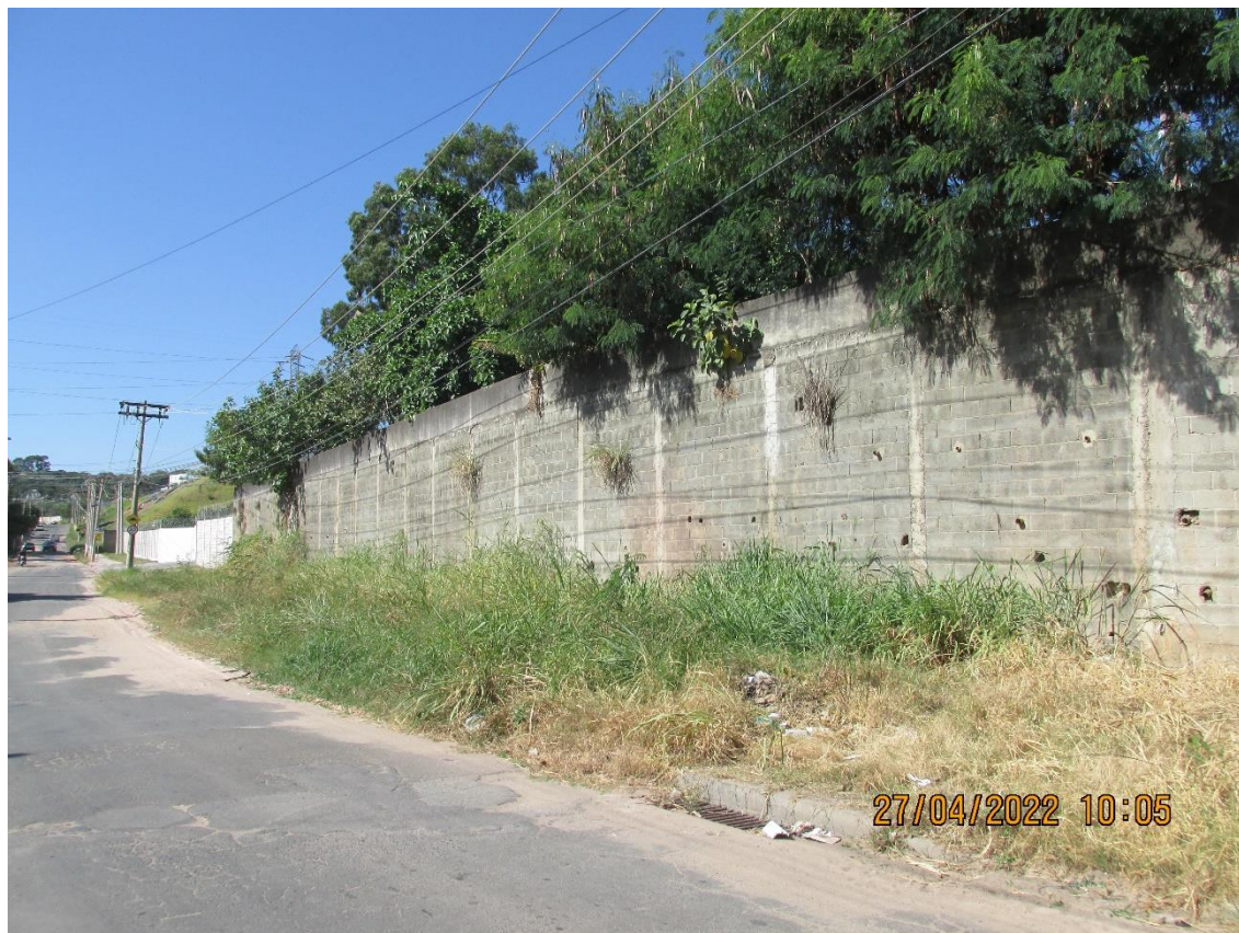
Fachada Imóvel Periciando
