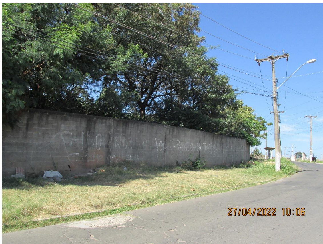
Fachada Imóvel Periciando
