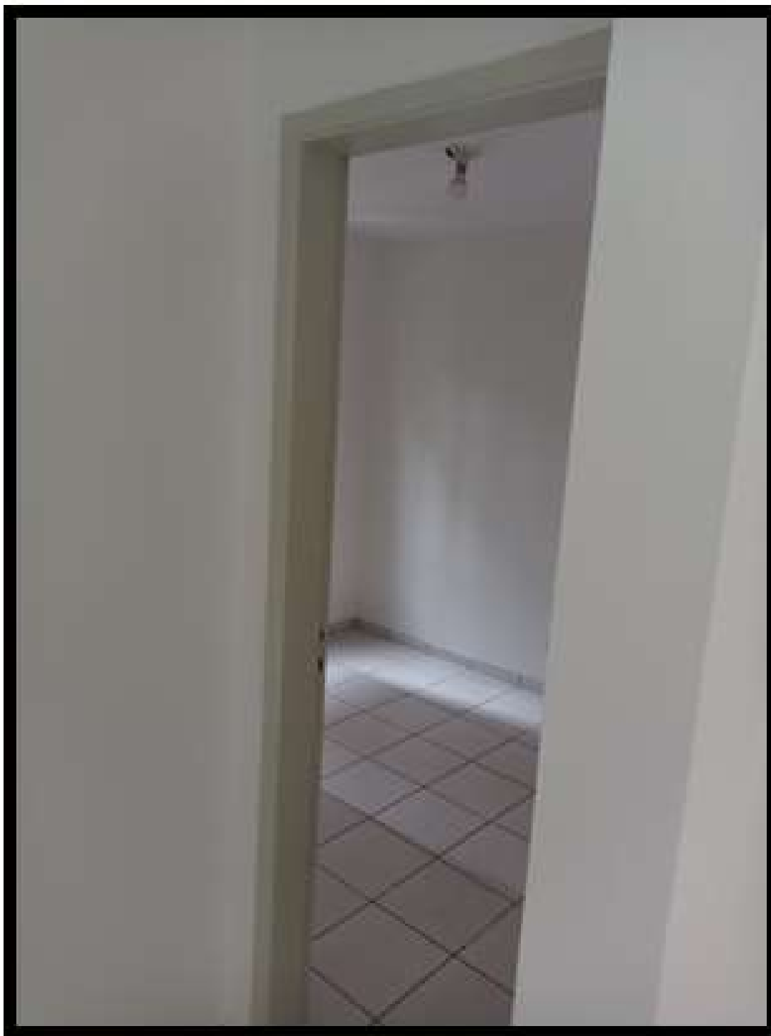
Foto nº 27: Vista quarto um do apartamento vistoriado
