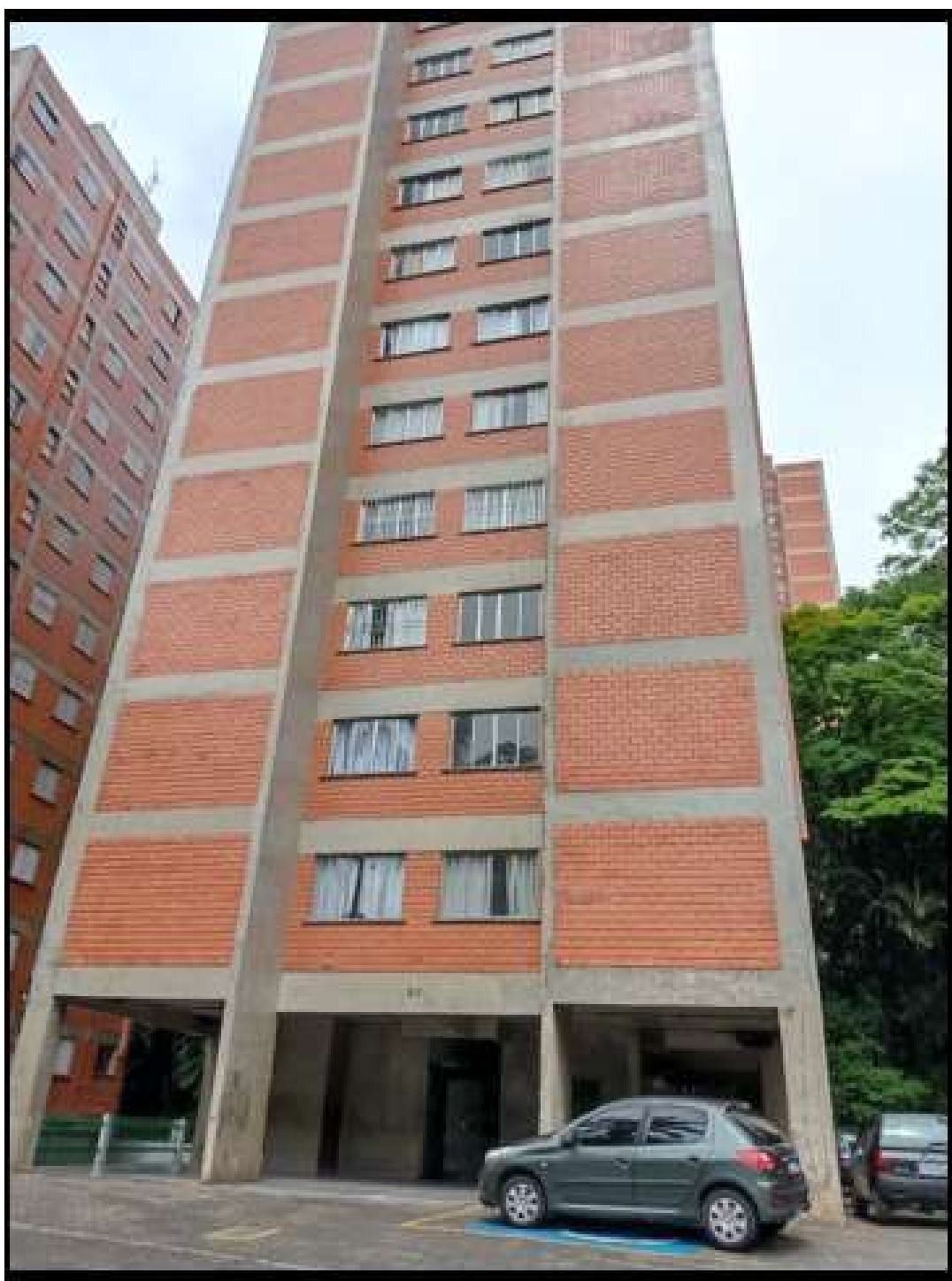
Foto nº 13: Vista da entrada “Bloco P”
