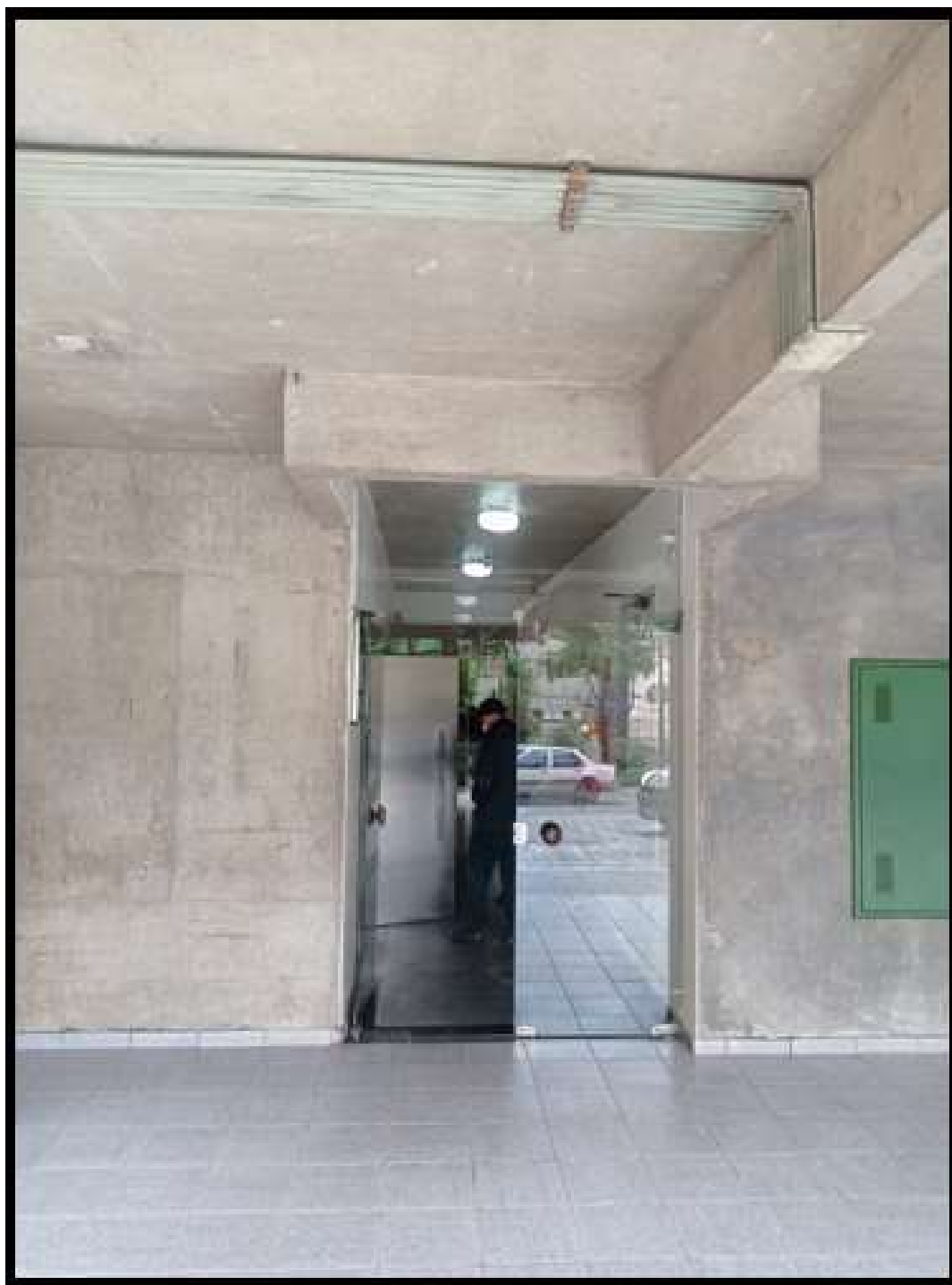
Foto nº 15: Vista do Hall de entrada do “Bloco P” do Residencial Floresta do Campo Limpo
