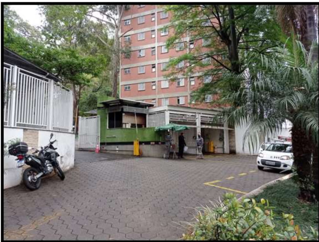
Foto nº 01: Vista dos portões de entrada e saída e guarita do Residencial Floresta de Campo Limpo
