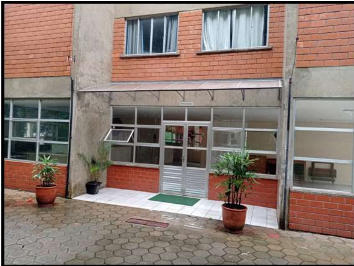
Foto nº 11: Vista da Espaço Gourmet na parte posterior do “Bloco Q”
