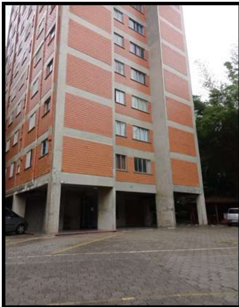
Foto nº 08: Vista da fachada frontal do “Bloco Q”
