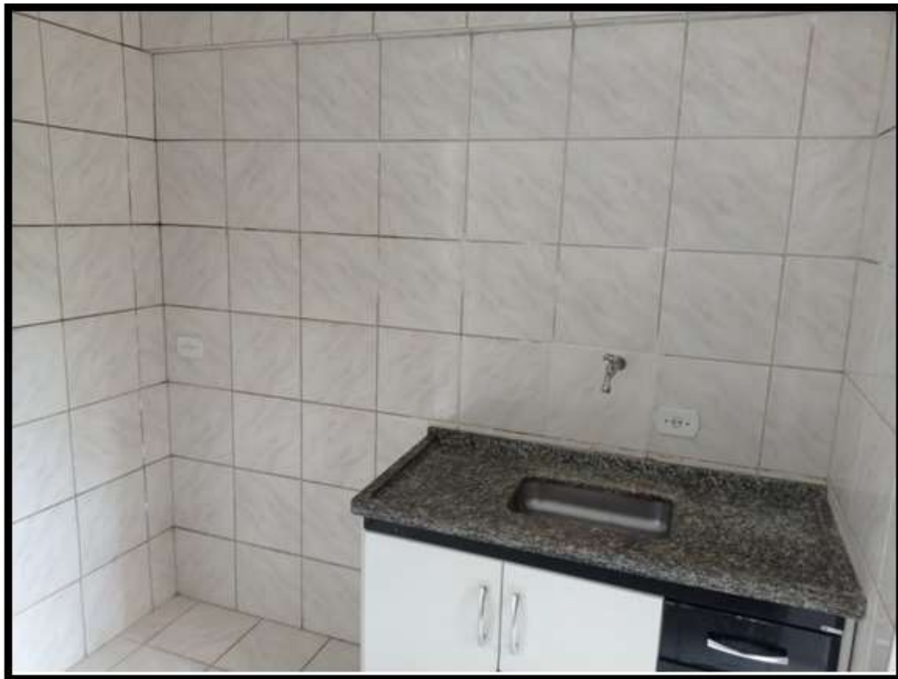
Foto nº 25: Vista da cozinha do apartamento vistoriado
