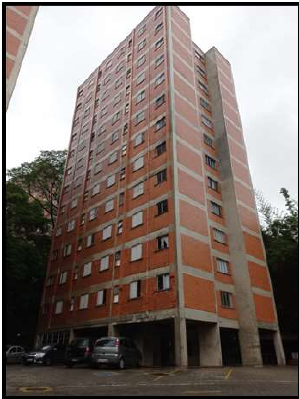
Foto nº 10: Vista da fachada lateral do “Bloco Q”
