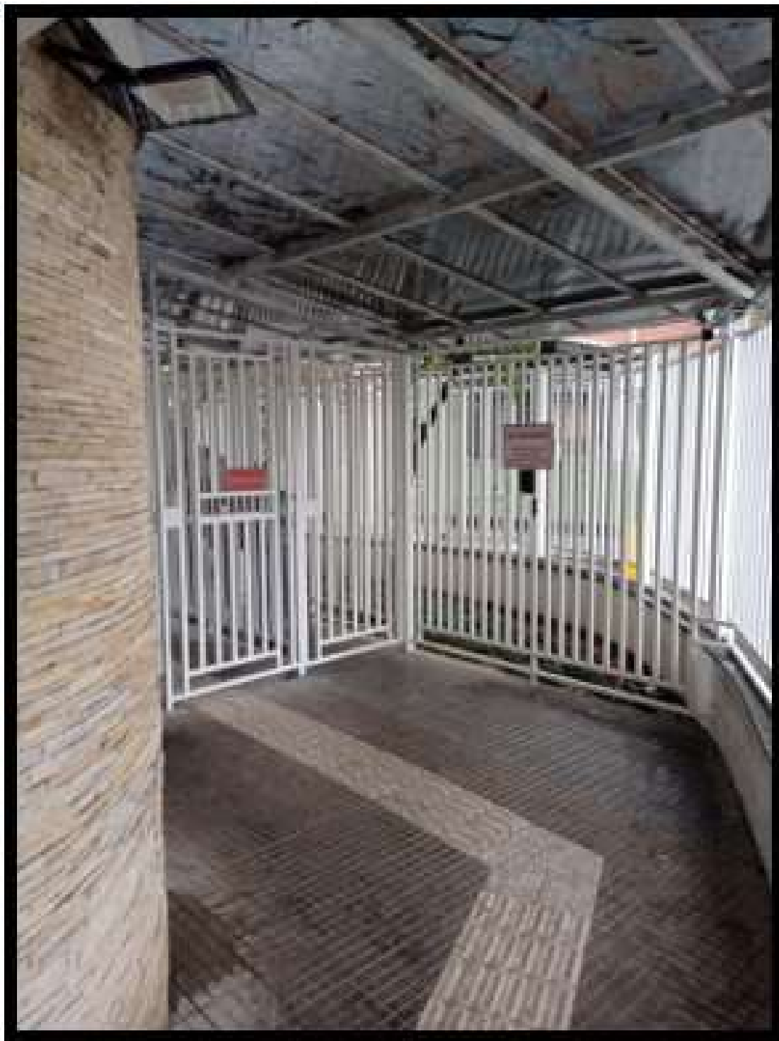
Foto nº 07: Vista do acesso de entrada e saída de pedestres do Residencial Floresta de Campo Limpo, por outro ângulo
