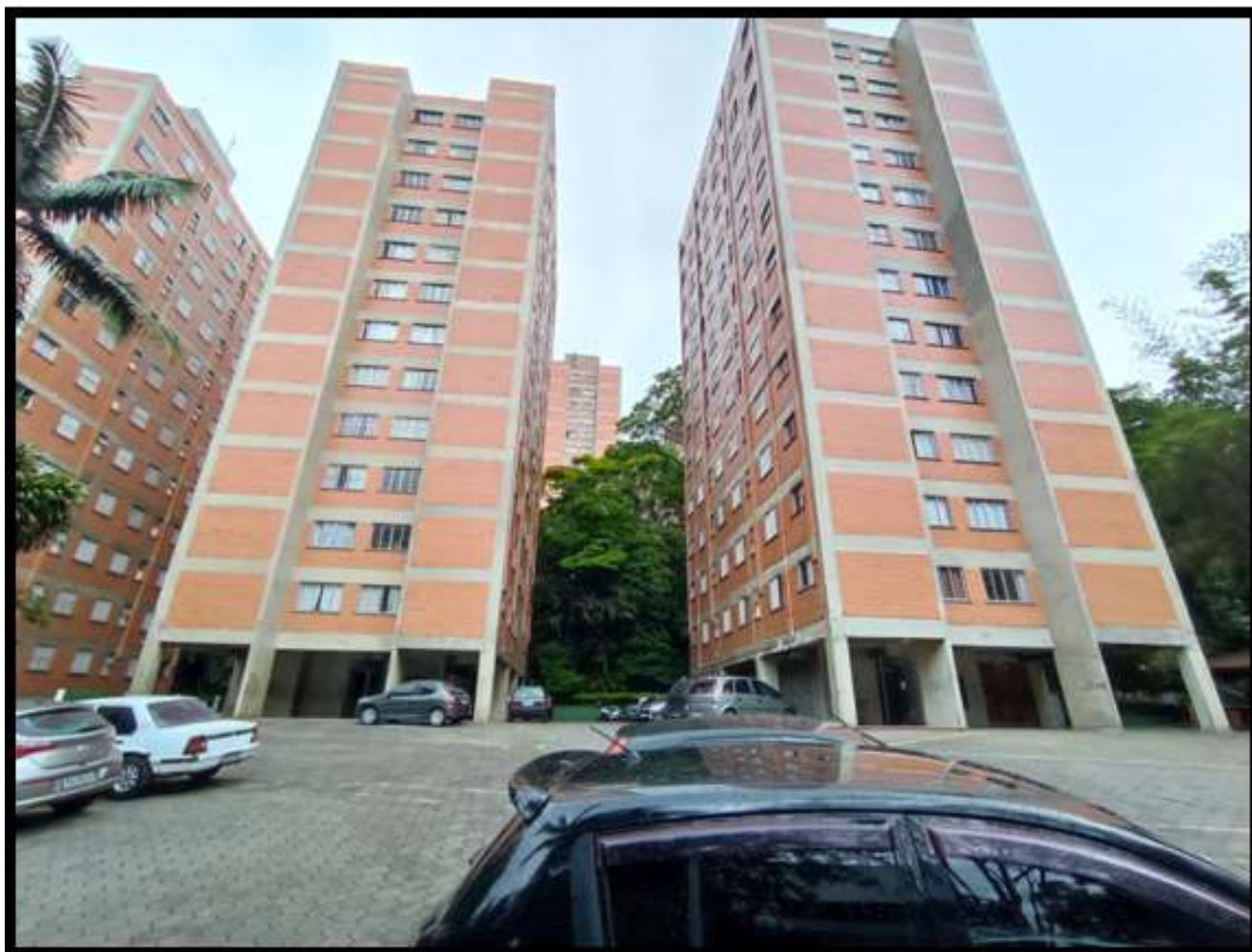
Foto nº 14: Vista do “Bloco P” e “Bloco Q” do Residencial Floresta do Campo Limpo
