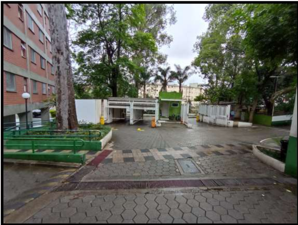
Foto nº 05: Vista interna dos portões de entrada e saída e guarita do Residencial Floresta de Campo Limpo
