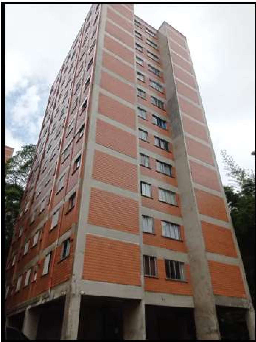
Foto nº 09: Vista fachada frontal do “Bloco Q”
