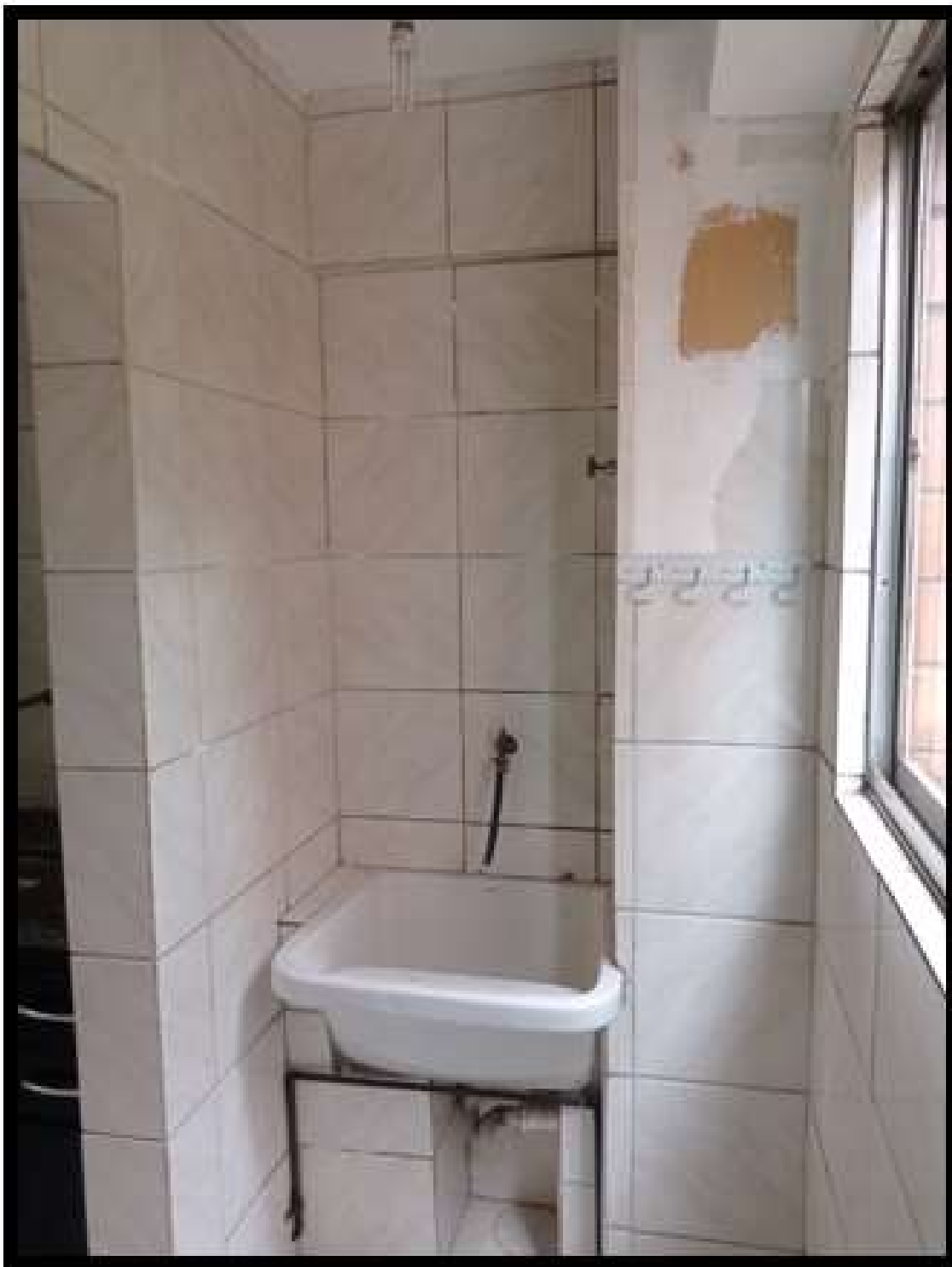
Foto nº 26: Vista da Lavanderia do apartamento vistoriado
