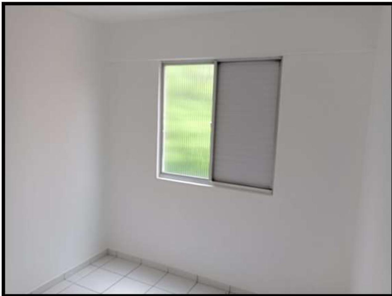
Foto nº 30: Vista do quarto dois do apartamento vistoriado
