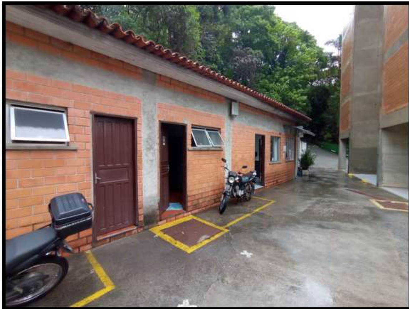
Foto nº 37: Vista Banheiro e Administração
