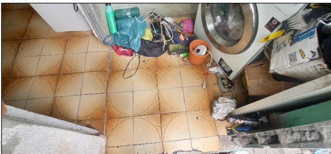
Foto 39. Área de Serviço
