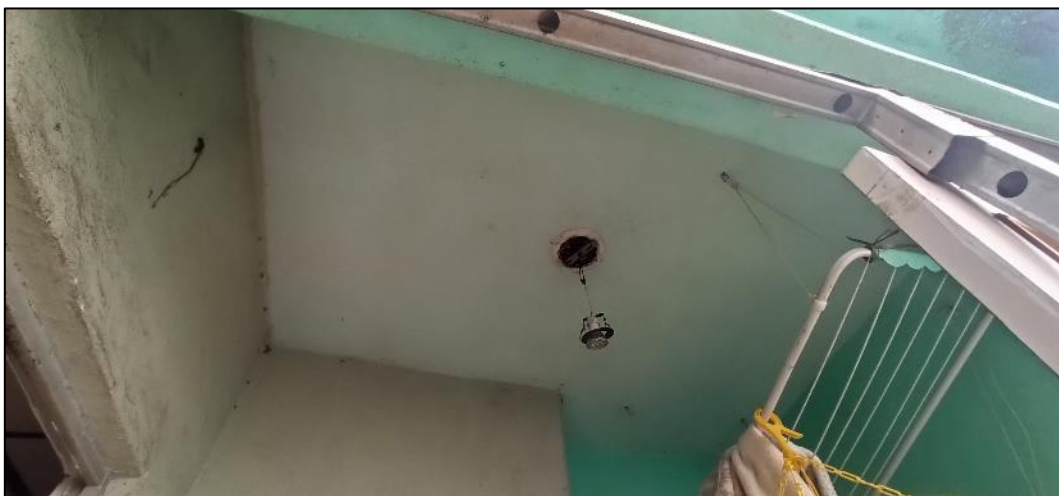
Foto 37. Área de Serviço
