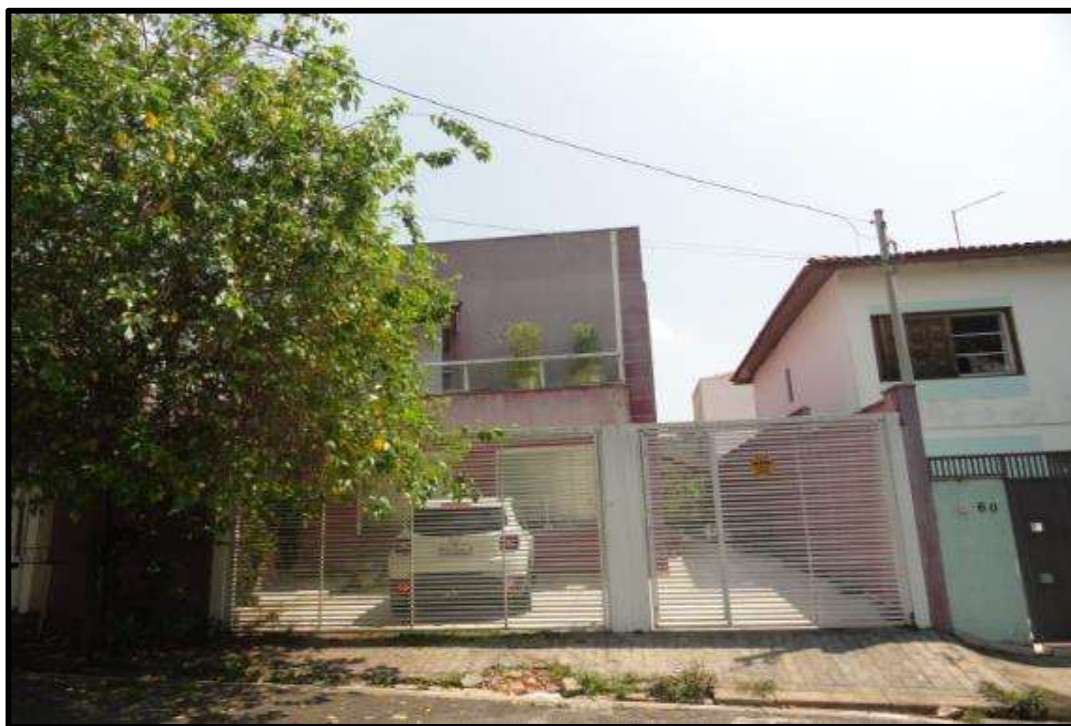
FOTO 2 – Vista frontal do imóvel avaliando.
