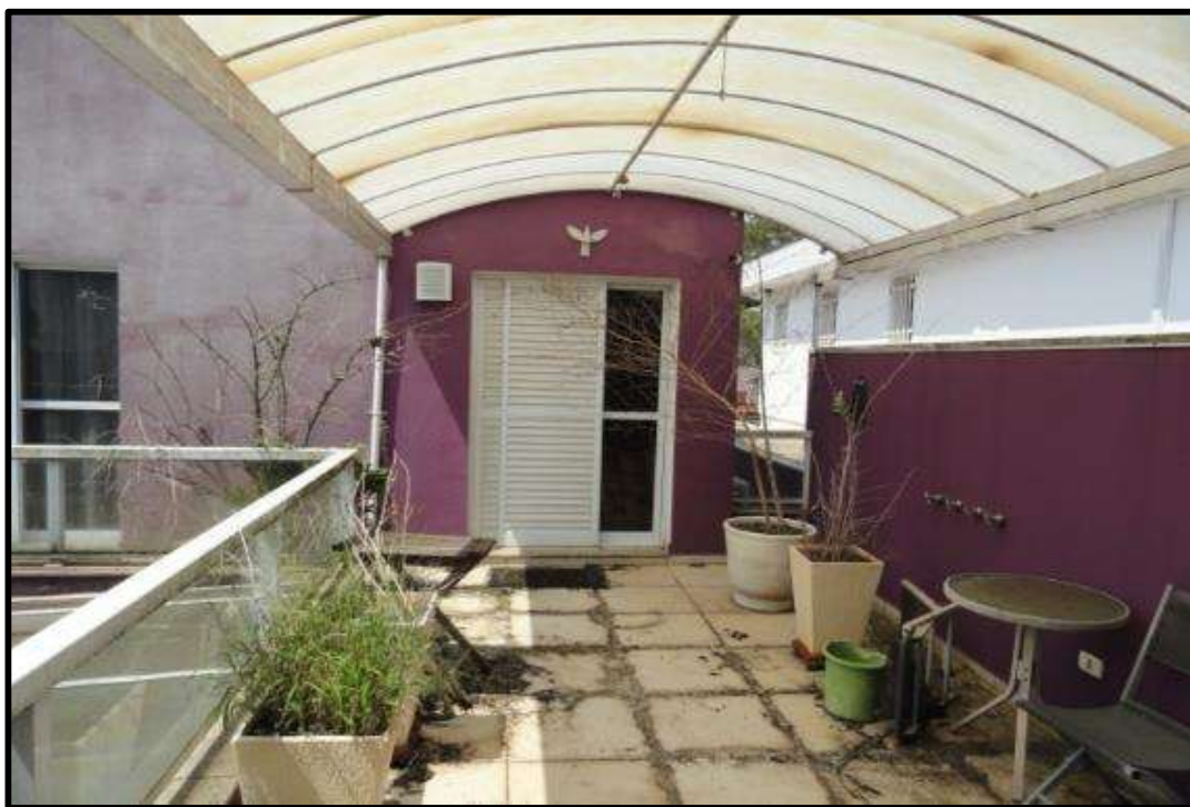
FOTO 20 – Acesso ao dormitório.
