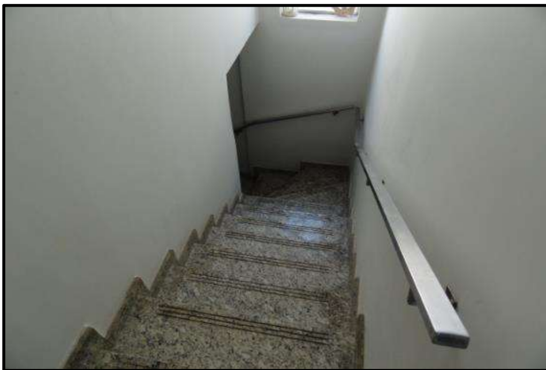
FOTO 22 – Escada de acesso ao pavimento superior.
