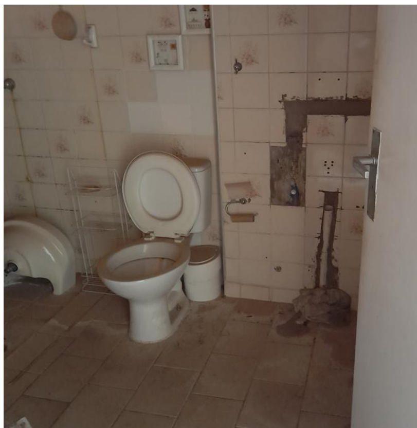
Vista do banheiro com detalhe para reparo de hidráulica e azulejos removidos.
