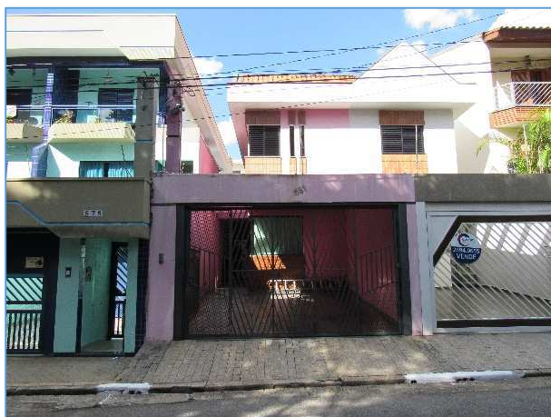
Fachada da edificação.
