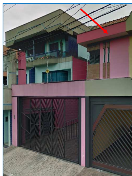
Aspectos da edificação.
