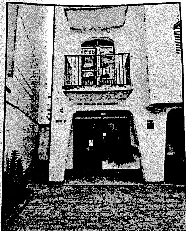
2. Vista do acesso ao edifício.
